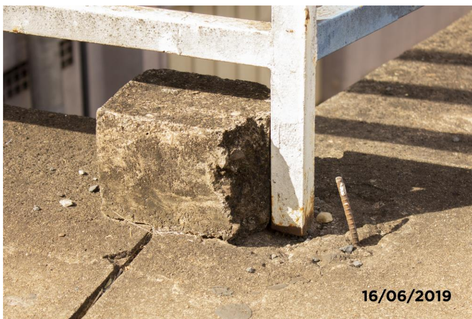
Foto 18A: Detalhe bloco de apoio do guarda corpo com deslocamento de concreto junto ao passeio e armadura exposta.
