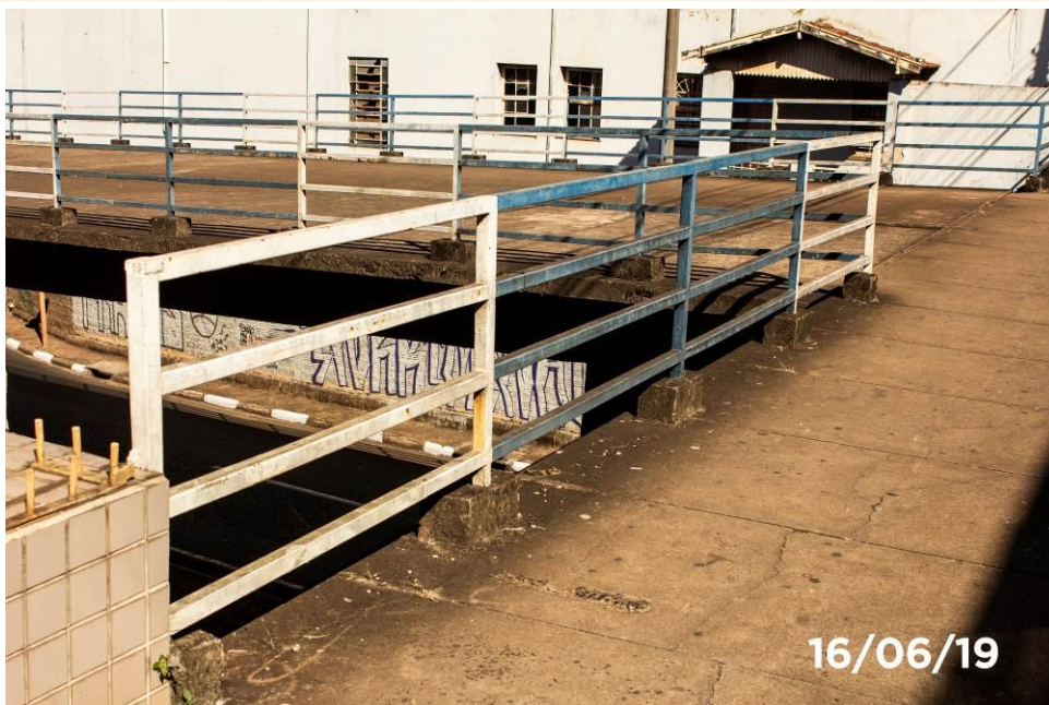
Foto 16: Vista dos pontos de corrosão, vegetação no bloco de apoio com o passeio.
