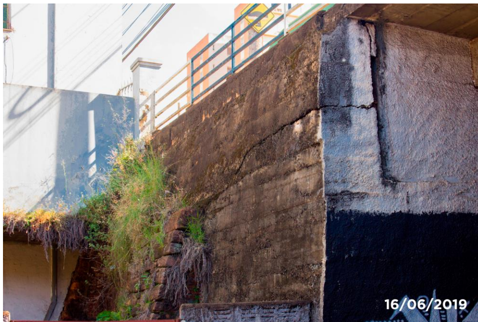
Foto 27: Detalhe da trinca existente no muro de arrimo e vegetação crescendo dentro da trinca.
