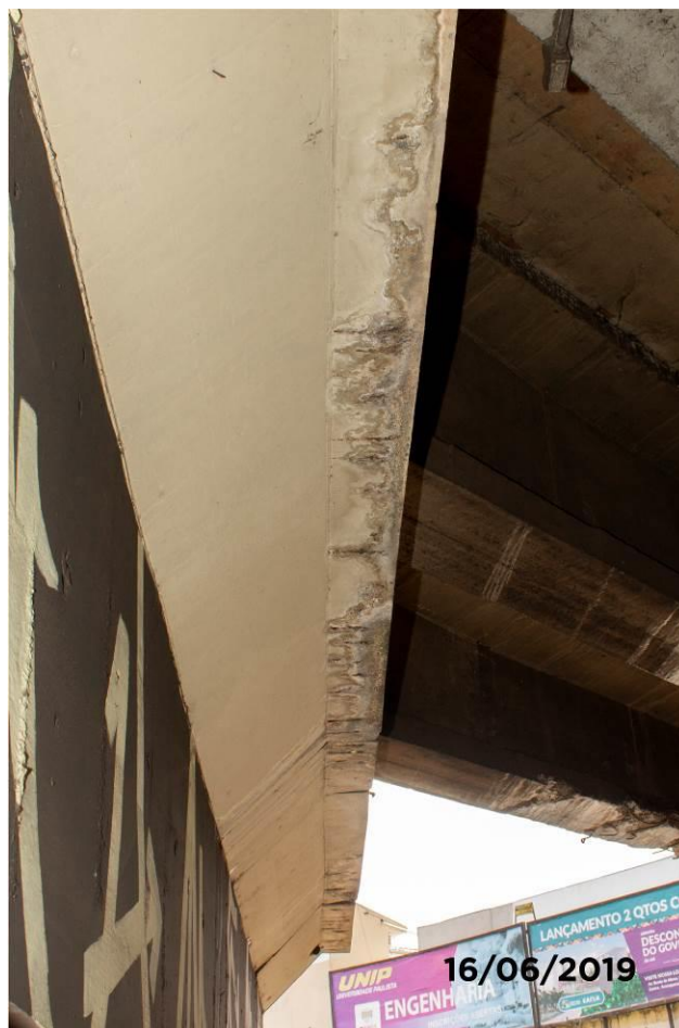
Foto 33: Armadura exposta na viga de travamento transversal sobre os pilares centrais.
