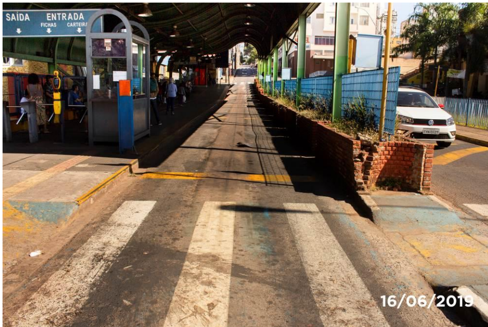
Foto 01: Vista da face superior do tabuleiro.
