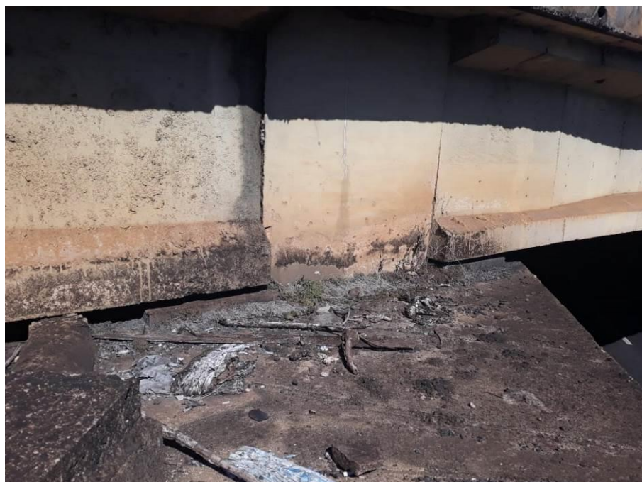
Foto 41: Detalhe da posição central, existe uma alvenaria entre as vigas.
