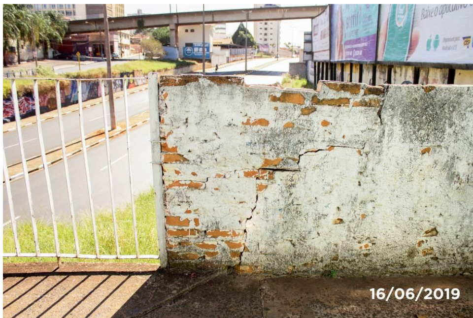
Foto 13: Detalhe da trinca na fixação entre o guarda corpo e o muro.
