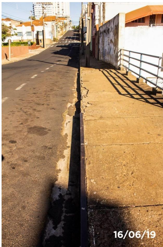
Foto 11: Vista do Passeio, com o deslocamento de concreto, trincas, e cantoneira metálica rompida.
