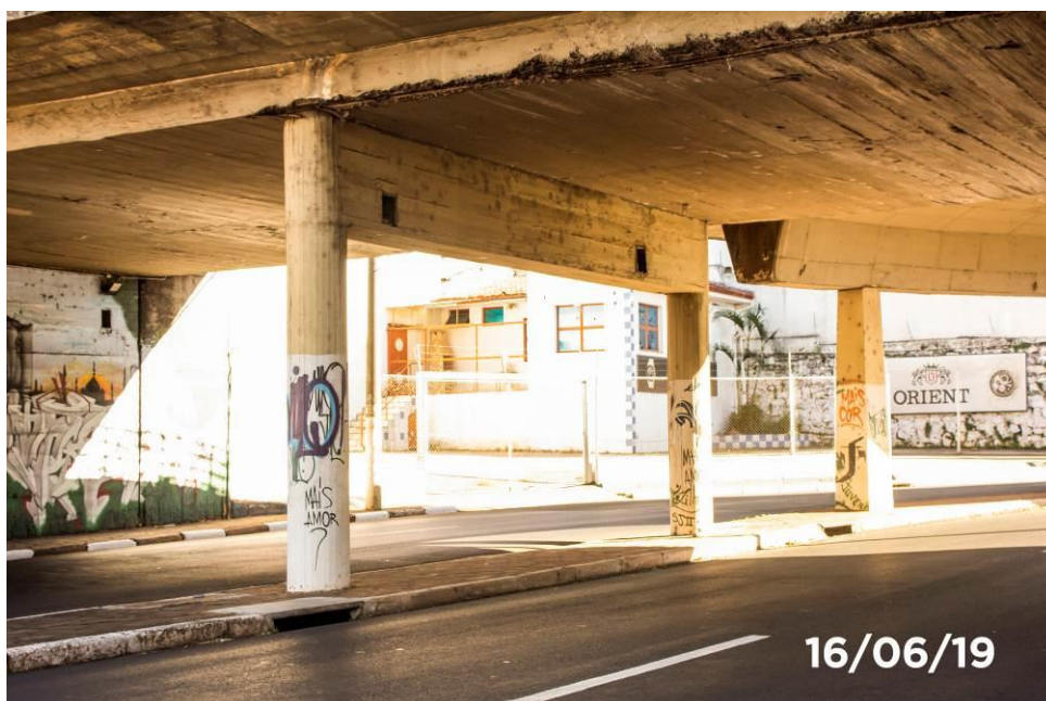
Foto 37: Vista dos pilares com a viga travessa apresentando bolor, caixa de passagem de elétrica sem tampa, armadura exposta e tubulação elétrica rompida, pilares sem proteção.
