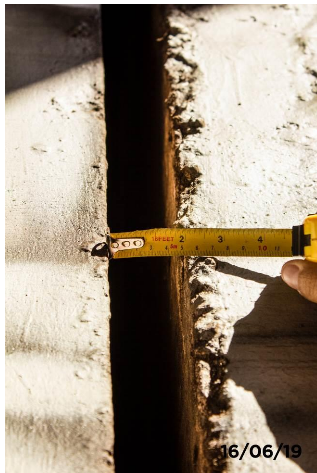
Foto 42: Detalhe da dilatação no muro de arrimo.
