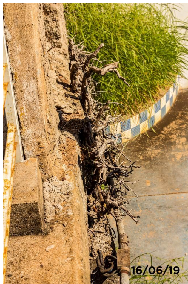
Foto 46: Detalhe da vegetação no muro de arrimo.
