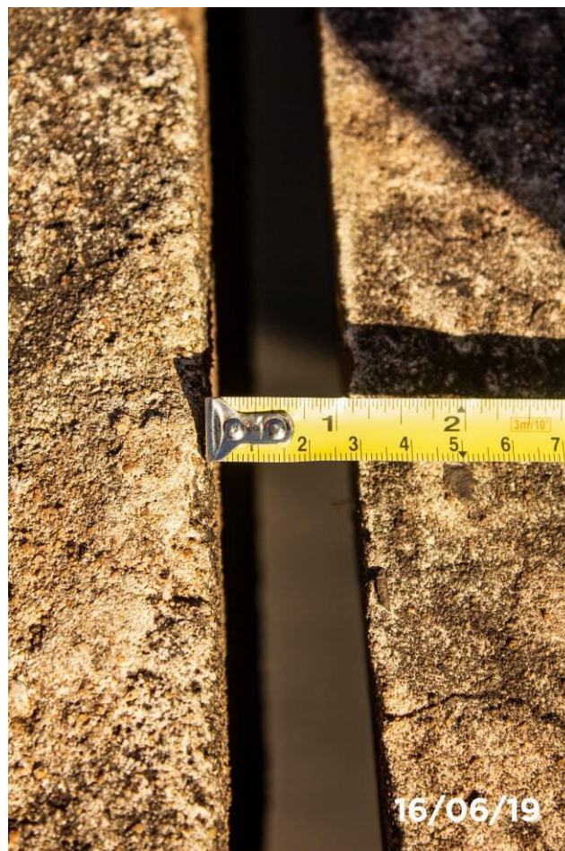
Foto 05: Detalhe da dimensão da junta de dilatação.
