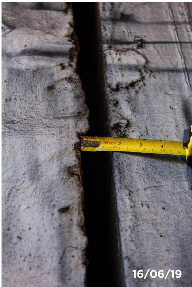
Foto 41: Detalhe da dilatação no muro de arrimo.
