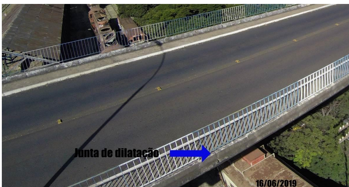
Foto 02: Vista da face superior do tabuleiro, apresentando dilatação no passeio do tabuleiro
