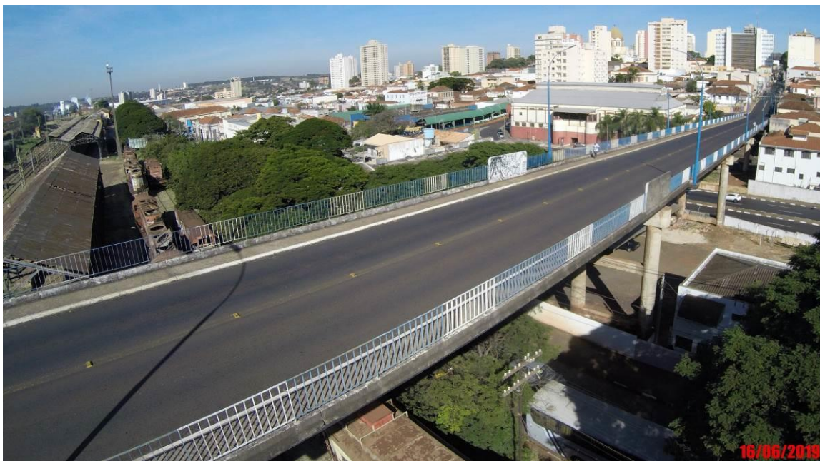
Foto 01: Vista geral da face superior do tabuleiro.
