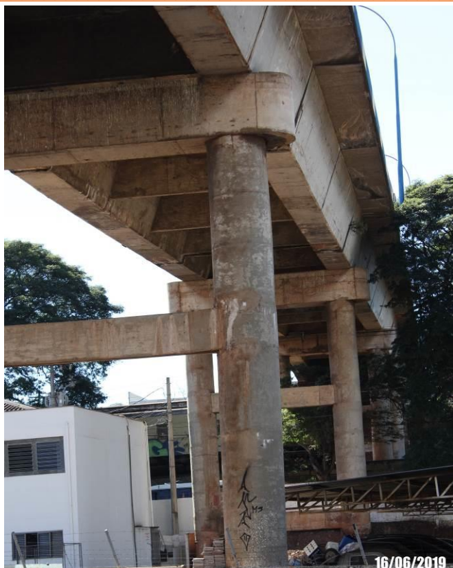
Foto 54: Vista de pilares com pequenas fissuras, pontos de deslocamento de concreto e eflorescência.
