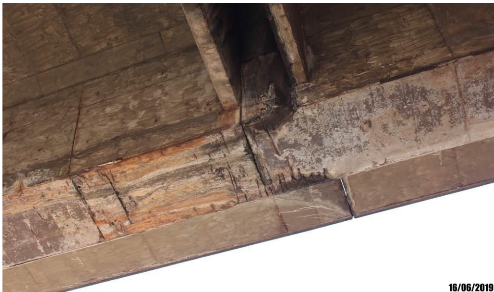
Foto 46: Detalhe da face inferior da viga com armadura exposta e infiltração na junta de dilatação.
