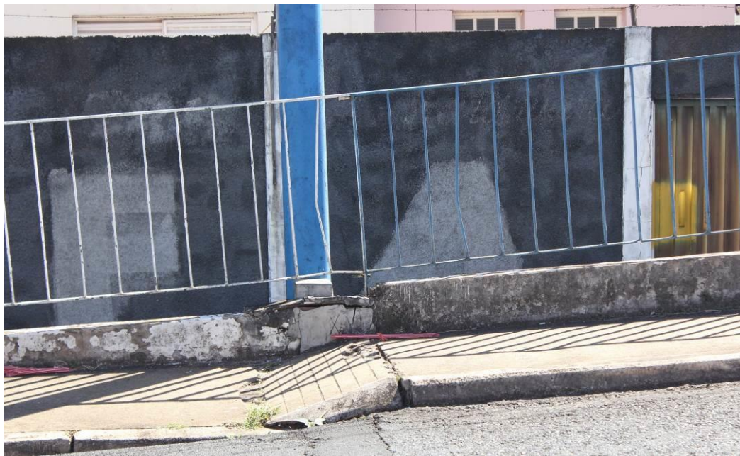
Foto 24: Detalhe do G.C. torto e do ponto de apoio dos postes de iluminação com concreto desagregado. Detalhe também do acesso ao passeio com rampa inadequada.
