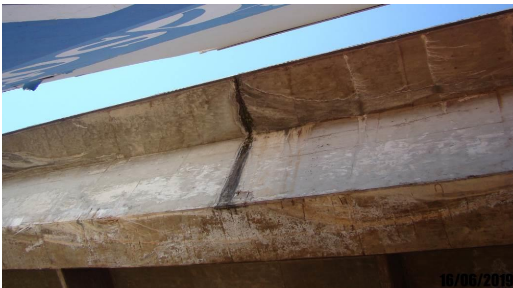
Foto 47: Detalhe da face inferior da viga com armadura exposta e infiltração na junta de dilatação.
