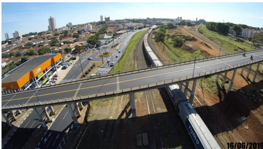
Foto 01: Vista geral da face superior do tabuleiro.
