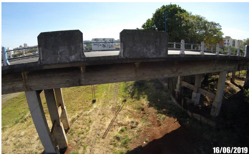
Foto 38: Vista da viga principal com infiltração na junta, eflorescência e deslocamento de concreto no apoio do guarda corpo.
