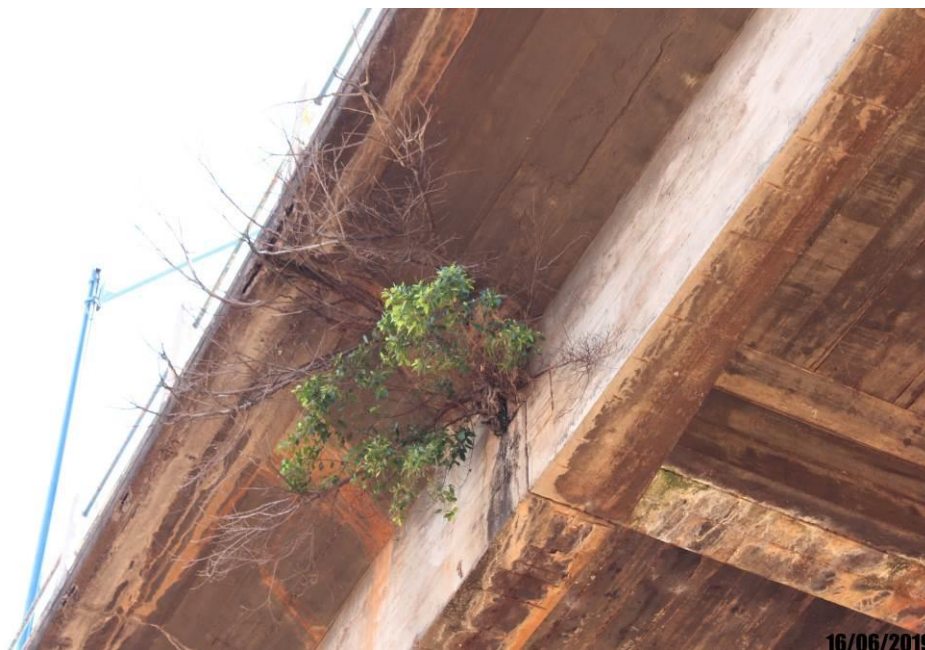
Foto 40: Detalhe de vegetação nascendo dentro da junta de dilatação, na lateral da viga principal.
