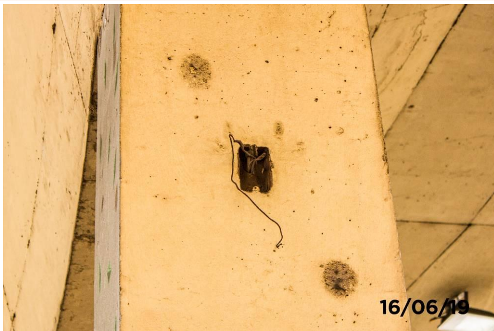
Foto 40- Detalhe da caixa de passagem de elétrica sem fechamento e com a fiação exposta.
