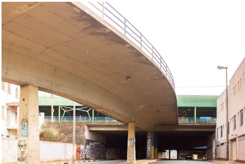
Foto 22- Vista da face inferior da estrutura (pilar+viga de travamento+laje) da passarela apresentando armadura exposta na viga de travamento e na laje, eflorescência na laje e na viga, infiltração vinda da rachadura na face superior do tabuleiro e mofo nos pilares
