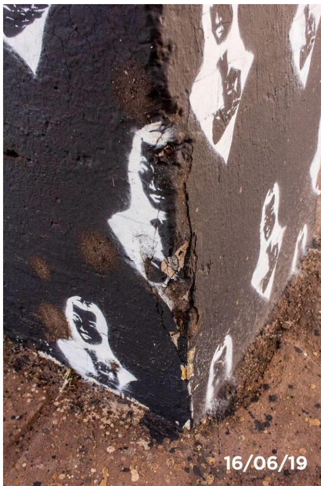
Foto 44 - Detalhe segregação do concreto, trincas, deslocamento do concreto do pilar, pontos aparentes de bolor, devido a infiltração de água no concreto
