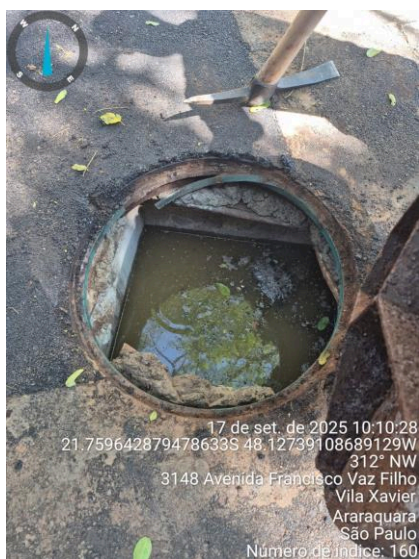
Figura 01 – Poço de Visitação entupido
