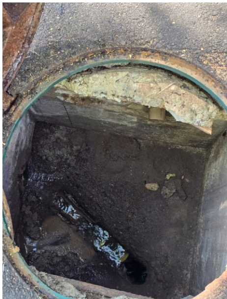
Figura 03 – Diâmetro de 100 mm e havia vazamento da tubulação sanado pelo DAAE
