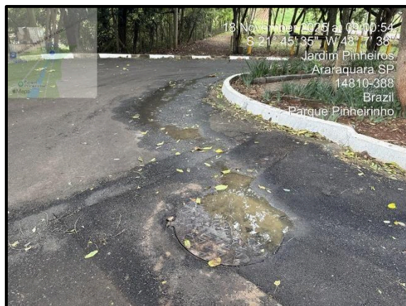
Figura 32 – Vazamento do PV (esgoto) na saída da Zoonoses/Bem-Estar Animal que, segundo servidores do parque, recebe manutenção semanal do DAAE. Neste ponto, há estrangulamento da rede coletora.
