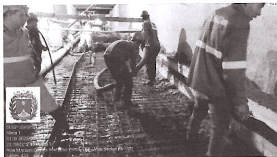
Foto 3 – Durante execução da laje de fundo
