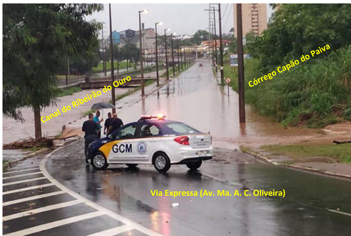
Figura 15. Vista da confluência entre o Córrego Capão do Paiva e o Ribeirão do Ouro, interditada de devido à insuficiência da seção de vazão da travessia.
