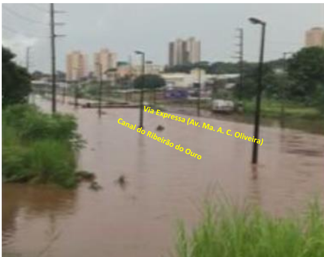
Figura 9. Vista dos alagamentos na Via Expressa e do canal do Ribeirão do Ouro transbordando durante chuva intensa.
