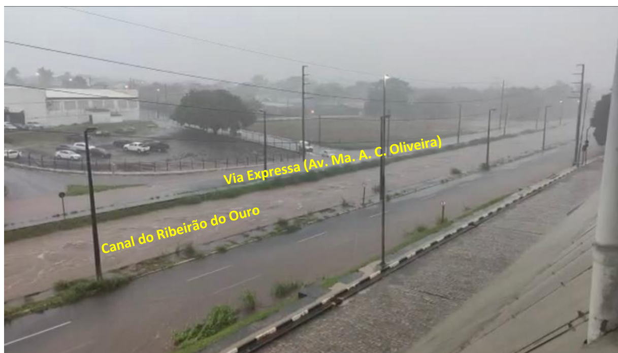
Figura 8. Vista dos alagamentos na Via Expressa e do canal do Ribeirão do Ouro praticamente transbordando durante chuva intensa.
