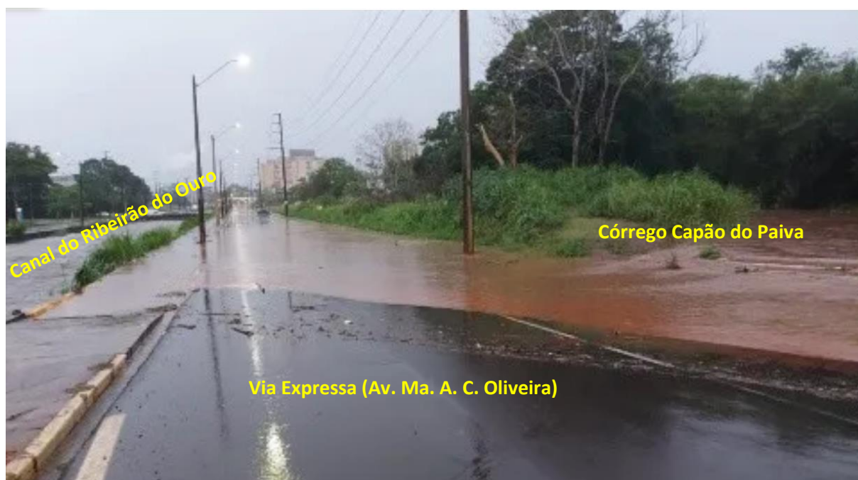
Figura 13. Vista da confluência entre o Córrego Capão do Paiva e o Ribeirão do Ouro, sendo que devido à insuficiência da seção de vazão da travessia do córrego sob a Via Expressa, a água passou por cima da pista.
