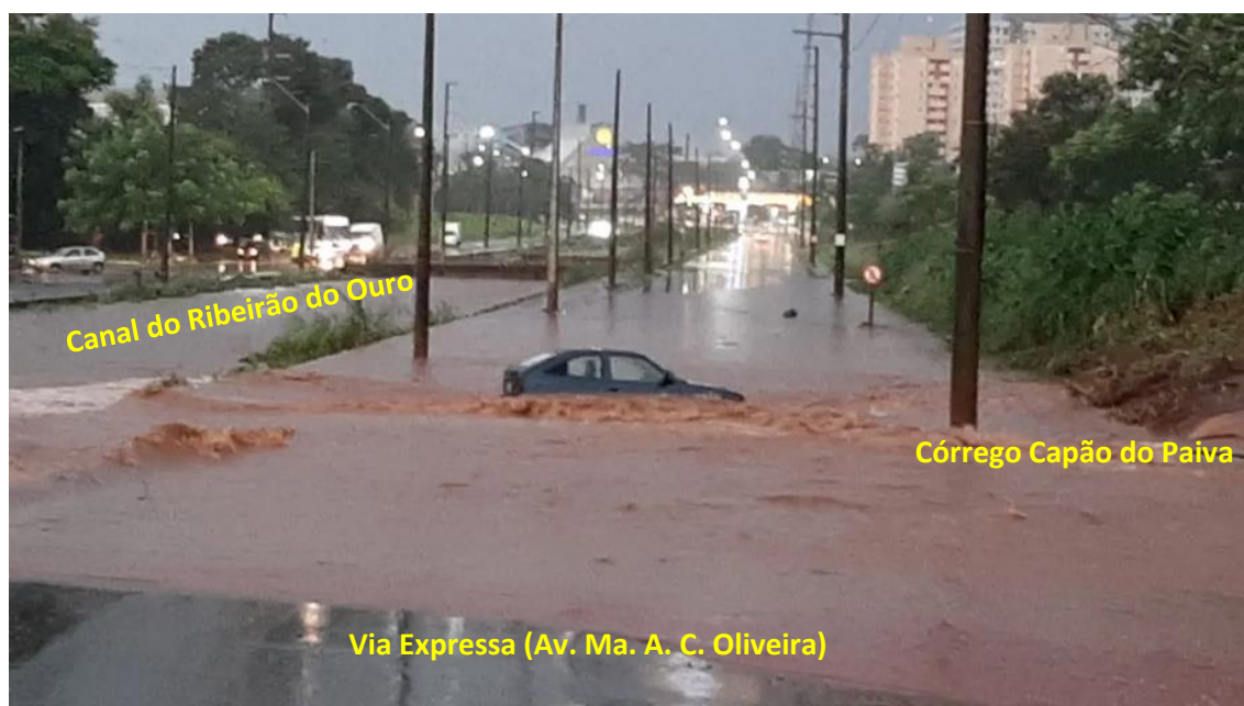
Figura 14. Vista da confluência entre o Córrego Capão do Paiva e o Ribeirão do Ouro, em outro momento, colocando em risco os usuários da via, quando que devido à insuficiência da seção de vazão da travessia do córrego sob a Via Expressa, a água passou por cima da pista
