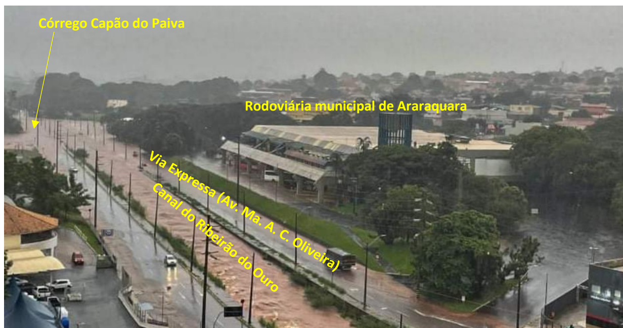
Figura 7. Vista aérea de alagamento ocorrido na Via Expressa nas proximidades da rodoviária de Araraquara.
