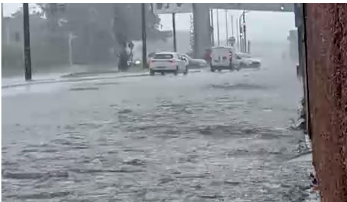
Figura 22. Vista de alagamento em outro ponto da Via Expressa sobre o Córrego da Servidão.
