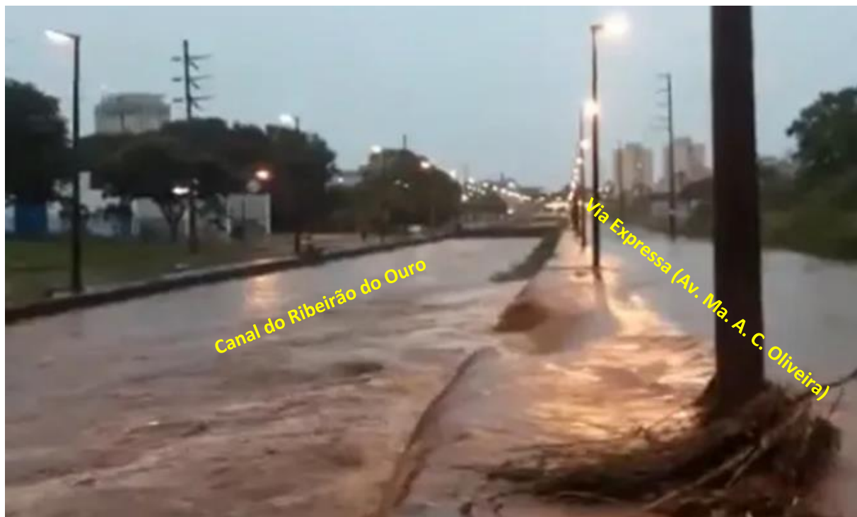
Figura 12. Vista de outro momento em que o canal do Ribeirão do Ouro não suportou as vazões escoadas pela bacia.
