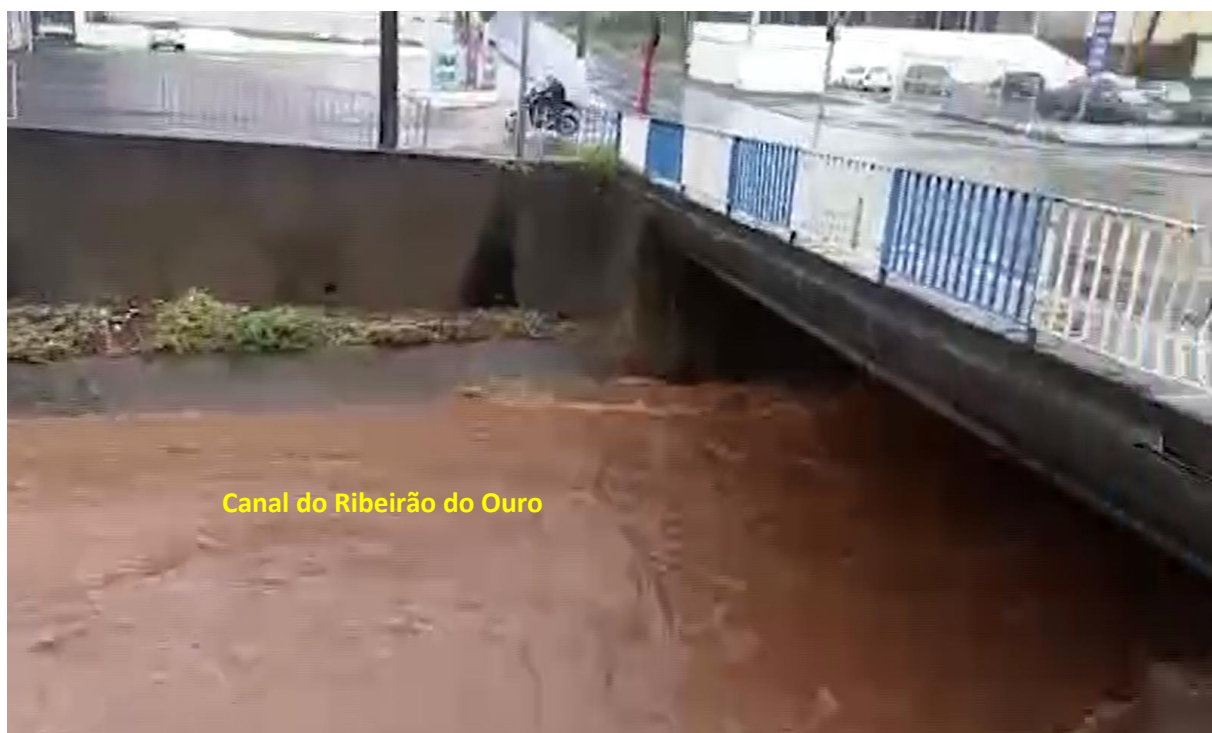
Figura 11. Vista 2 do escoamento no Canal do Ribeirão do Ouro após o fim das chuvas.
