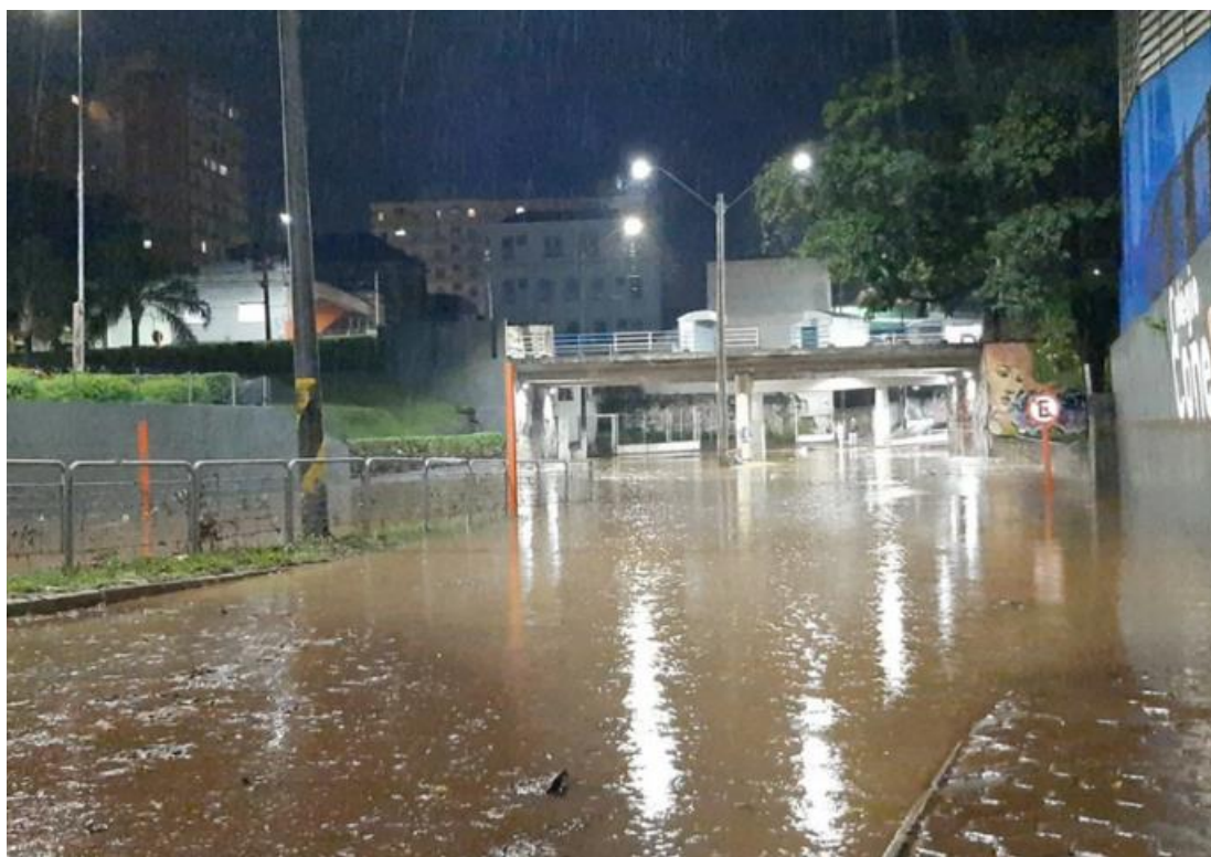
Figura 19. Vista da Via Expressa, na região do terminal de ônibus urbanos durante uma chuva intensa, com alagamento em ambas as pistas e interdição completa da via.
