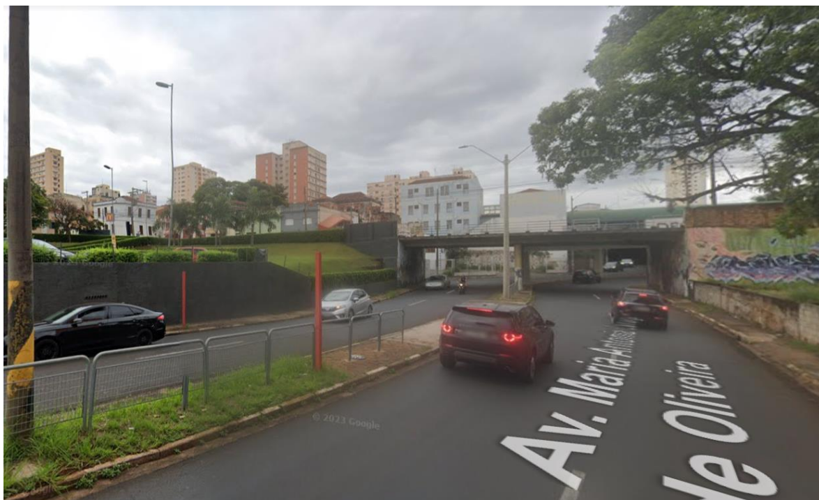
Figura 17. Vista da Via Expressa sobre o Córrego da Servidão (canalizado com seção de contorno fechado) em dia normal, sem chuva.
