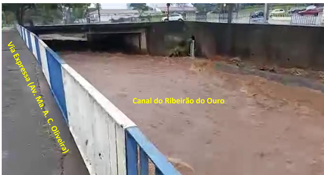
Figura 10. Vista 1 do escoamento no Canal do Ribeirão do Ouro após o fim das chuvas.
