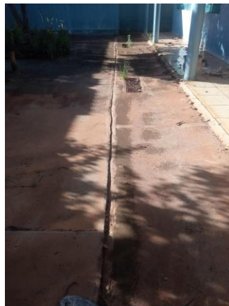
Demolição de piso recalques
