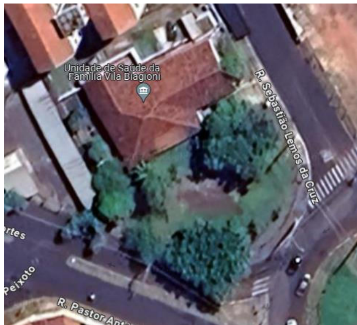
Vista da Unidade – (Imagem Google Earth)
