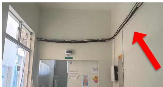
Junto ao prédio anexo (entre calçada e alvenaria), adequar a instalação elétrica que atualmente está aparente, com instalação de eletroduto apropriado.
