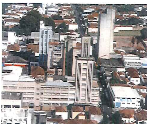
Fábrica antiga no centro
