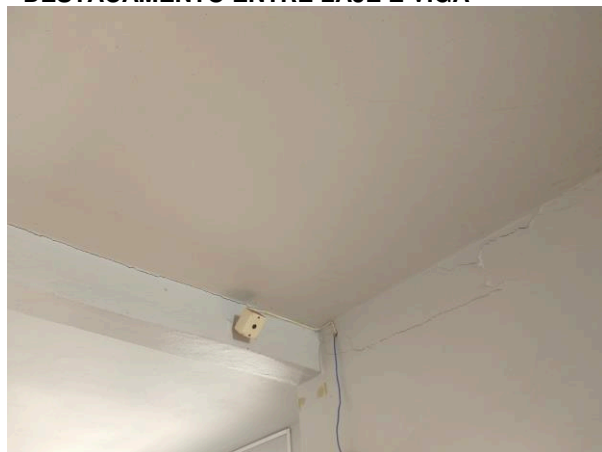
DESTACAMENTO ENTRE LAJE E VIGA
