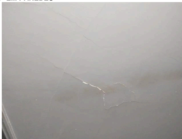
RACHADURAS 45° EM PAREDES
