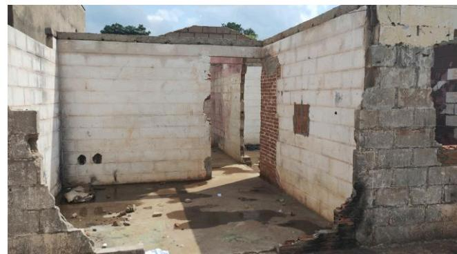
**No momento em que era realizada a vistoria que deu origem a este relatório, dois compartimentos se encontravam com acúmulo de água de chuva cobrindo toda a superfície do compartimento.**
