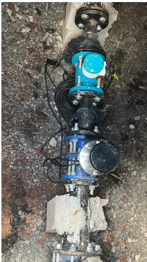
01 Medidor de Vazão Dn 50mm– 01 Válvula Borboleta Dn 100mm
