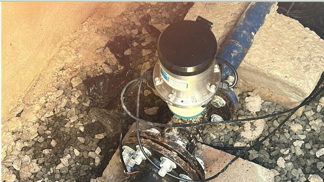
01 Medidor de Vazão Dn 50mm– 02 Válvula Borboleta Dn 150mm
