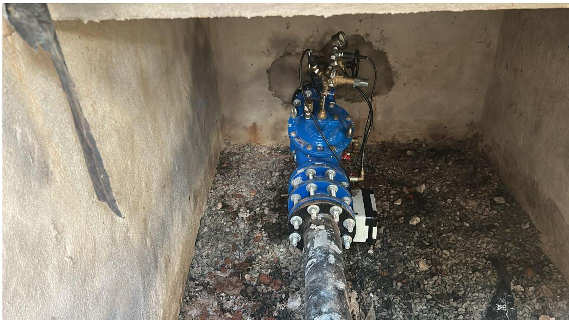
01 Medidor de Vazão Dn 100mm– 01 Válvula Redutora de Pressão Dn 100mm
