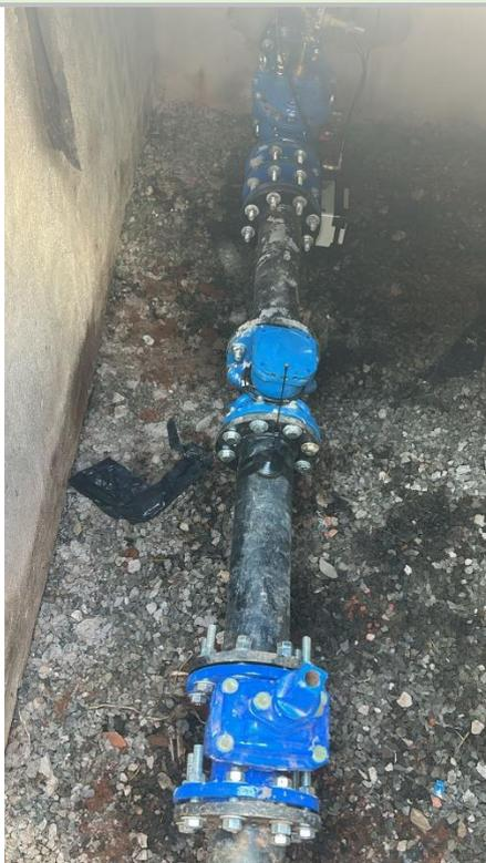
01 Medidor de Vazão Dn 100mm– 01 Válvula Redutora de Pressão Dn 100mm
