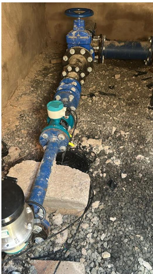
01 Medidor de Vazão Dn 50mm– 02 Válvula Borboleta Dn 150mm
