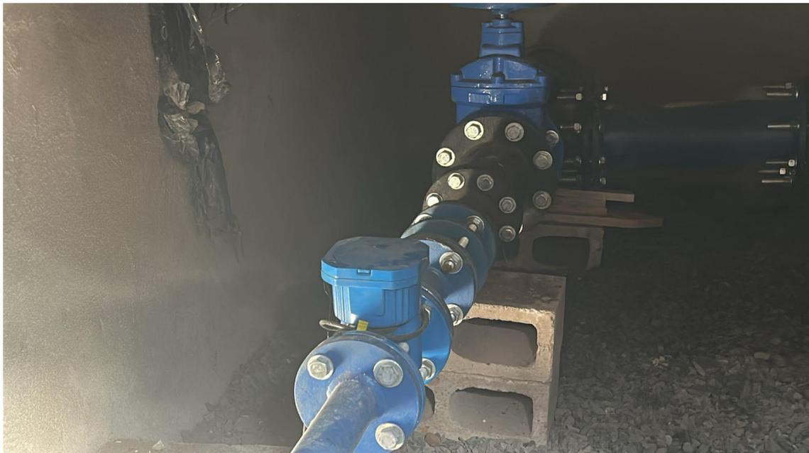
01 Medidor de Vazão Dn 50mm– 01 Válvula Borboleta Dn 150mm
