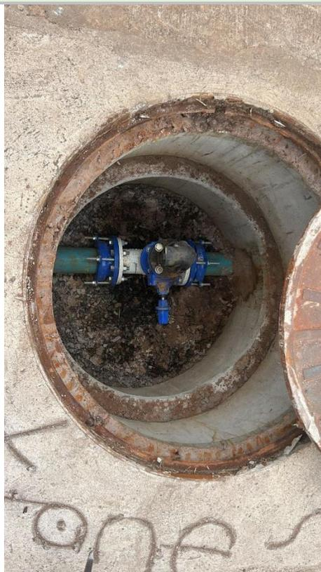
01 Válvula Borboleta e FºFº 100mm – JE – 01 Ventosa de Tríplice Função Dn 50mm
