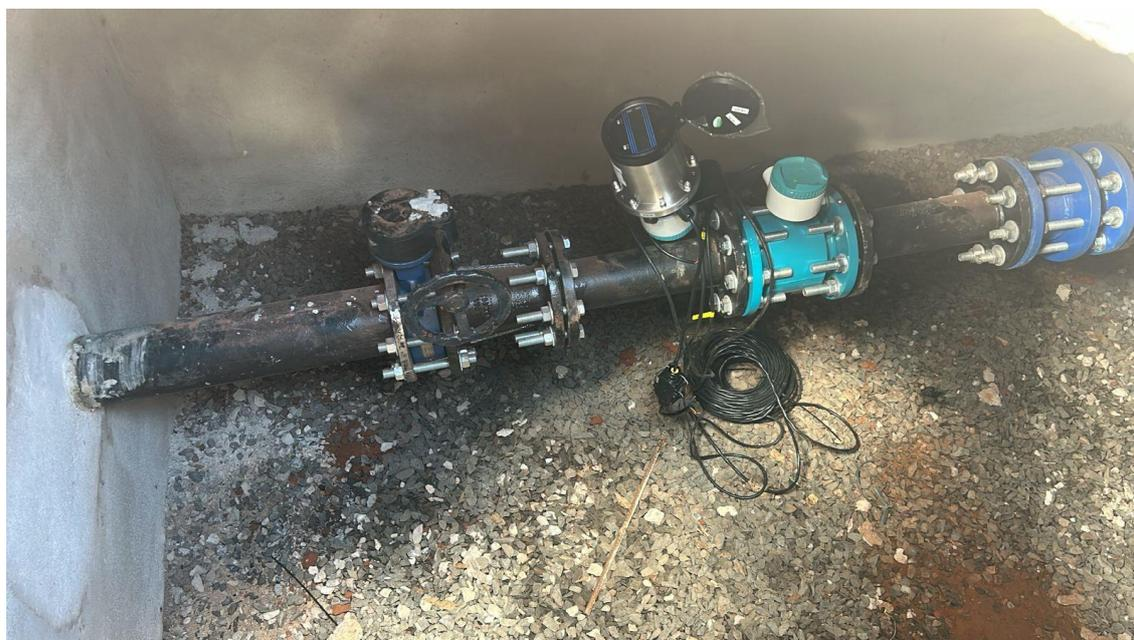
01 Medidor de Vazão Dn 80mm– 02 Válvula Borboleta Dn 100mm
