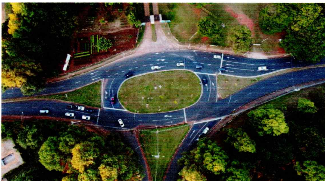
Figura 28. Demonstrativo da análise de tráfego de veículos na Área 01. Fonte: FH Engenharia Ambiental (2022)
