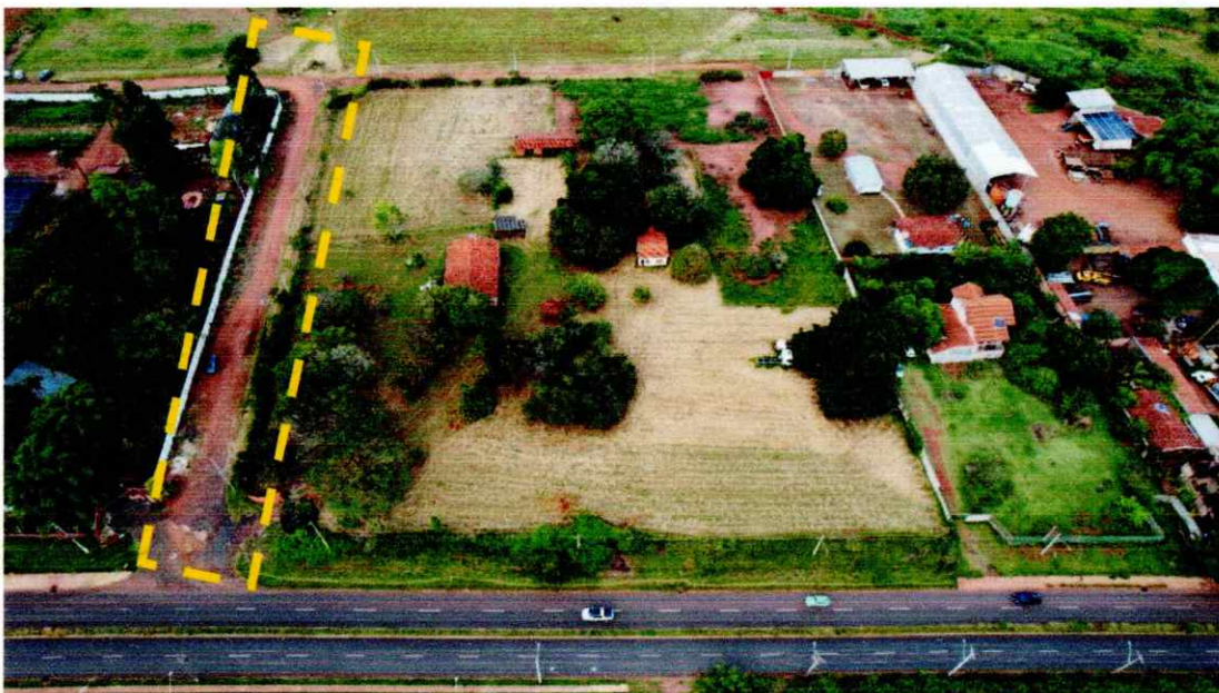
Figura 39. Trecho de via não pavimentada.
