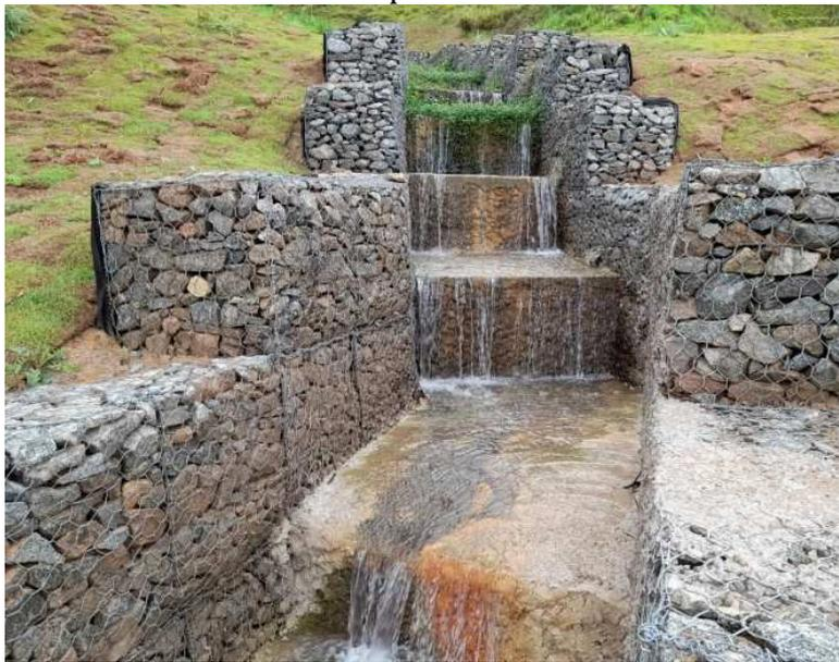
Imagem 10 – Escada hidráulica - Fonte: Blog da Belgo Engenharia
