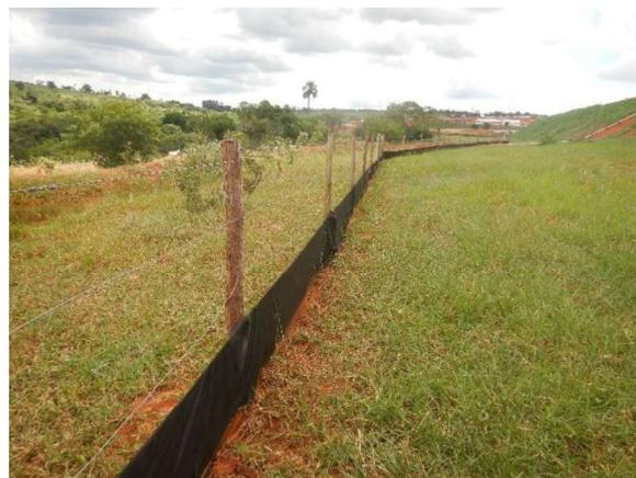
Foto 02. Barreira por manta geotêxtil para conter o escoamento superficial rumo à APP.
