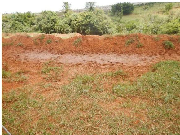
Foto 01. Curva de nível implantada para o barramento da água superficial.
