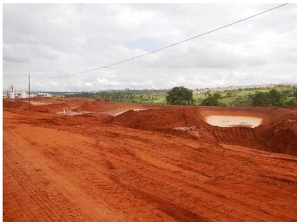
Foto 03. Detalhe do conjunto de bacias de contenção de sedimentos provisórias.
