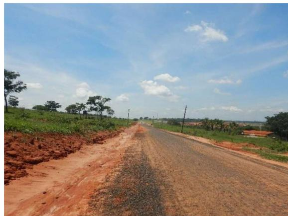
Foto 04. Rebaixo no terreno conformando canaleta na lateral da via para escoamento.
