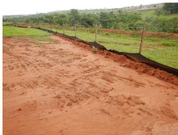
Foto 14. Evidência de sedimentos contidos pela manta demonstrando eficácia do sistema.
