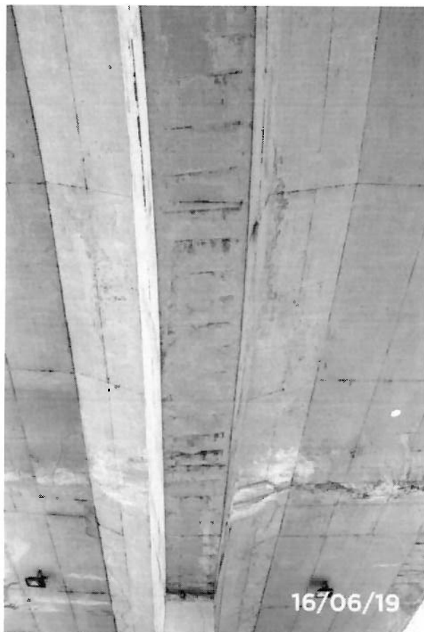
Foto 30 - Detalhe de eflorescência e armadura exposta.
