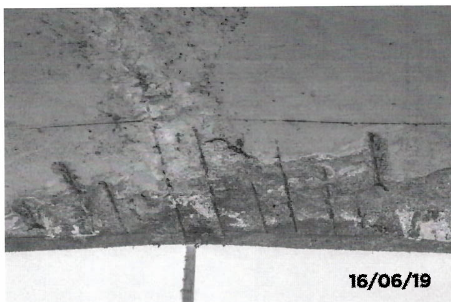
Foto 33- Detalhe de florescência e armadura exposta.
