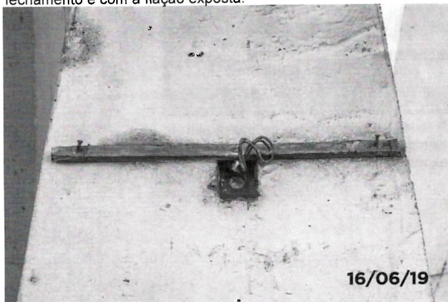
Foto 41- Detalhe da caixa de passagem de elétrica sem fechamento e com a fiação exposta.
