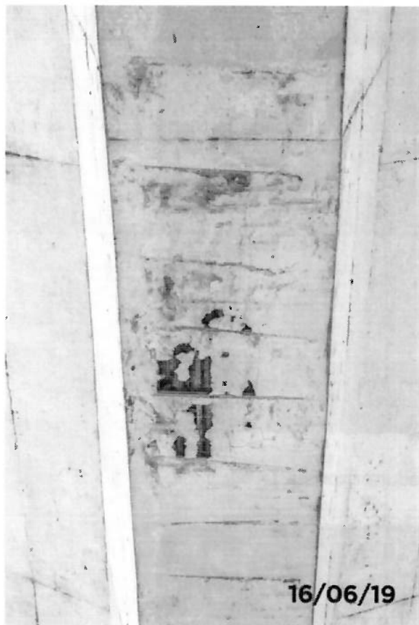
Foto 34 - Detalhe de armadura exposta na viga principal
