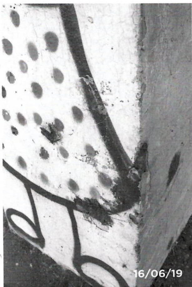
Foto 43 - Detalhe de segregação do concreto, trincas, deslocamento do concreto do pilar, pontos aparentes de bolor, devido a infiltração de água no concreto.
