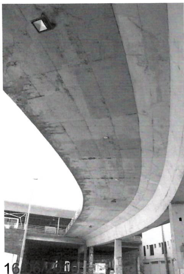
Foto 36 – Vista frontal inferior da Passarela, detalhe de ausência de pingadeira laterais, processo de infiltração e armaduras expostas
