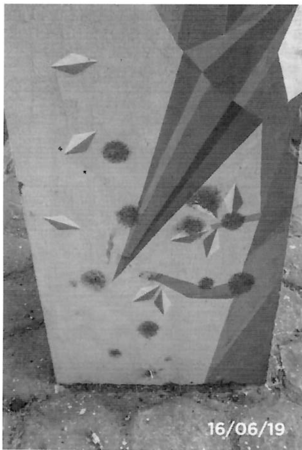
Foto 45 - Detalhe segregação do concreto, trincas, deslocamento do concreto do pilar, pontos aparentes de bolor, devido a infiltração de água no concreto
