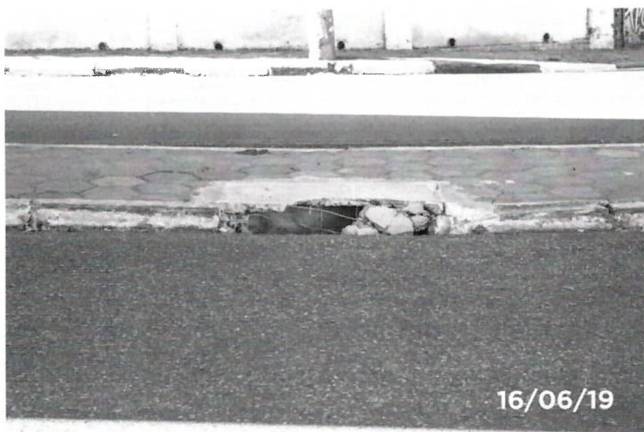
Foto 48- Detalhe boca de lobo danificada e obstruída.
