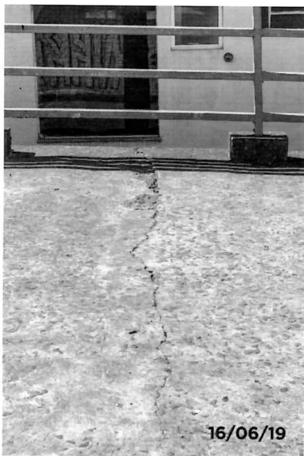
Foto 02 - Detalhe da rachadura e trincas no Tabuleiro.
