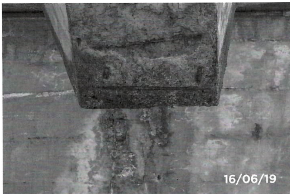
Foto 32- Detalhe de eflorescência e armadura exposta.
