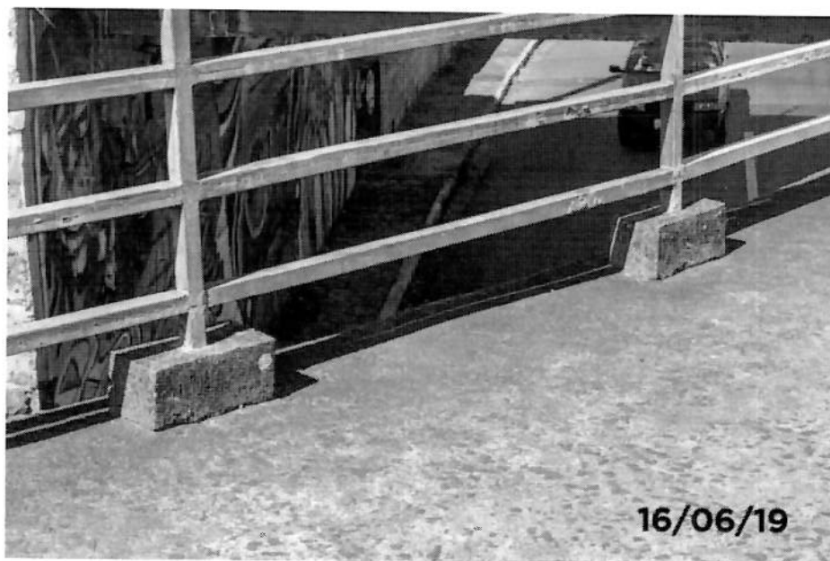
Foto 07- Destacamento do concreto do bloco e fixação da guarda corpo.
