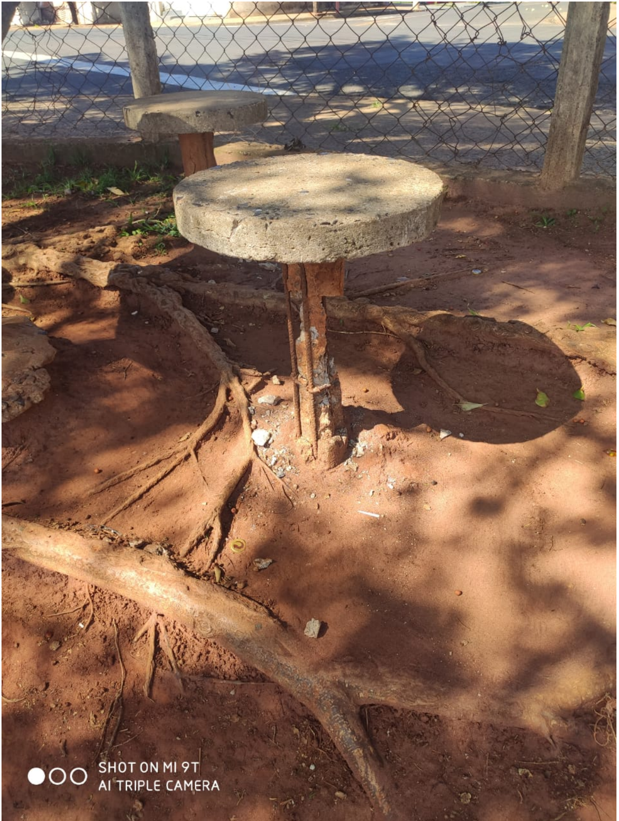
(Banco totalmente desprotegido do concreto)
