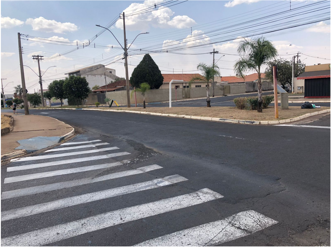
AVENIDA MAURICIO GALLI, PRÓXIMO AO COMPLEXO VIÁRIO BEBETO FERRAZ LUZ – VILA SEDENHO.
