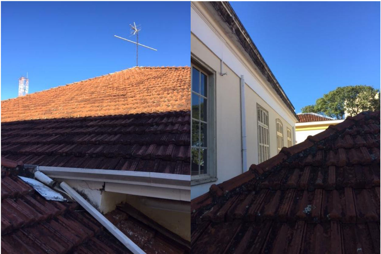
Fotos 3 e 4– telhado
