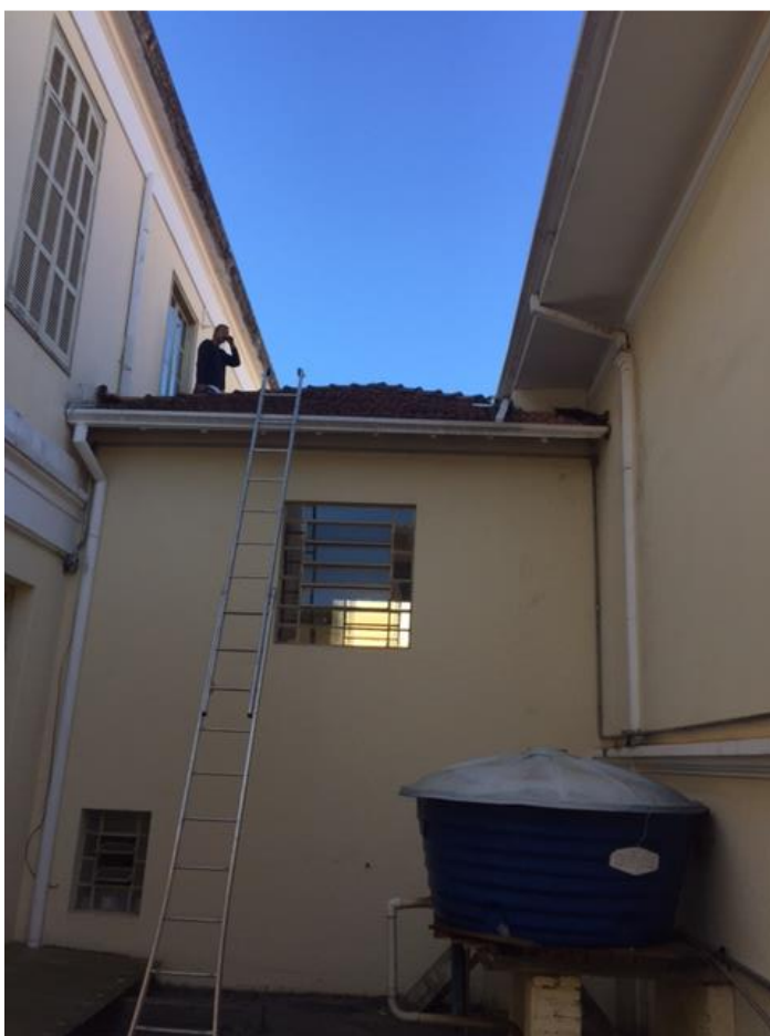
Foto 6 – Telhado – Revisão e reparo nos beirais, calhas e condutores. Fonte: Alessandra de Lima, 2017.
