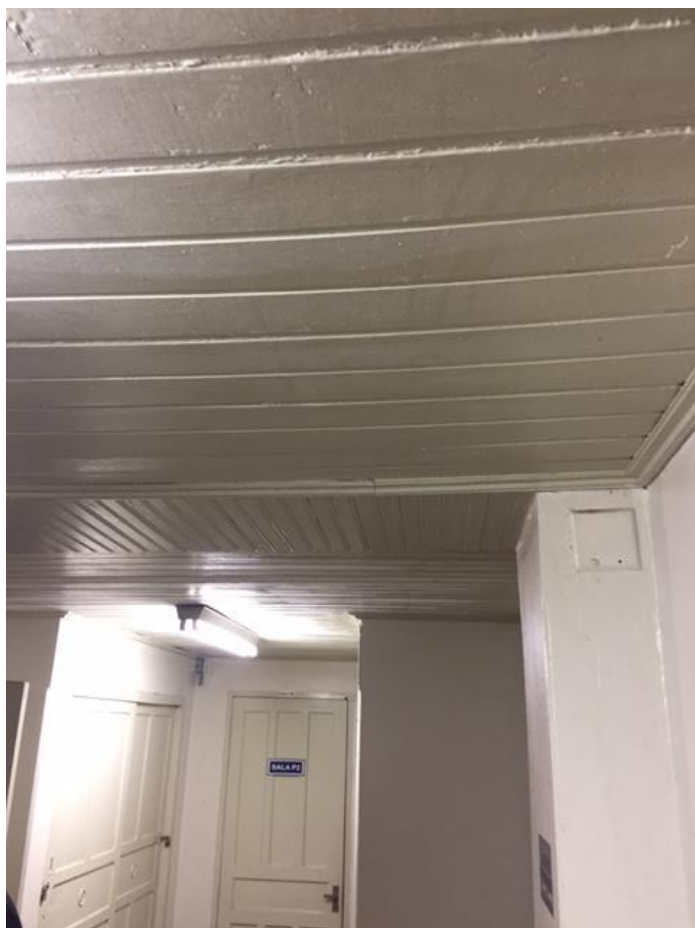
Foto 7 - do hall de serviço – da cozinha, sala de limpeza, salas P1 a P4. Esta foto nos mostra que o forro deve ser substituído, e a sugestão de PVC, não alterara as características do forro, nesta área de serviços e atividades de arte.
