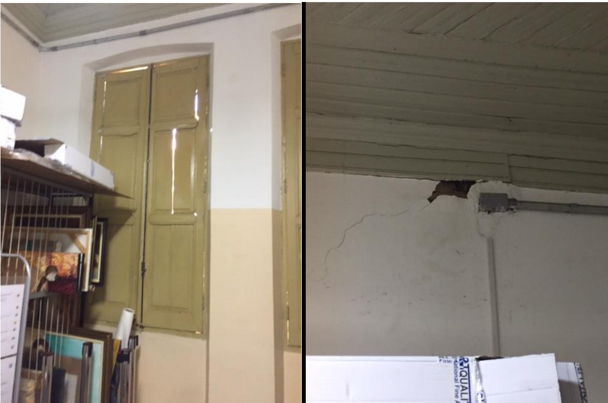
Fotos 34 e 35 - Sala Admin. 2. O batente será removido, pois estão com cupins e estragados e será instalado novo batente, a porta será recuperada. Piso, forro segue como já esclarecido. Fonte: Alessandra de Lima, 2017.
