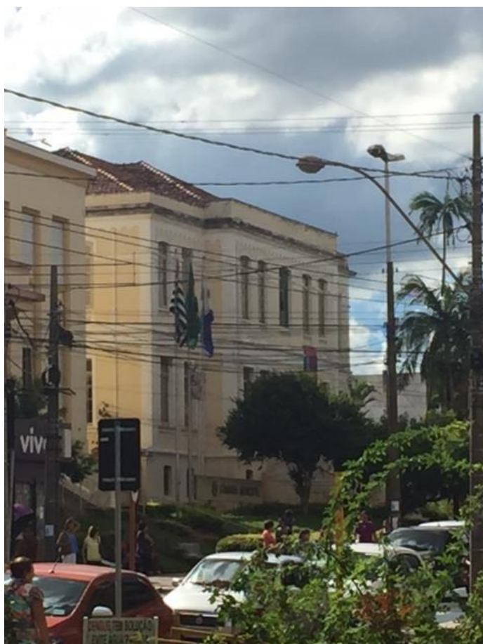
Foto 3 - Fachada da Casa da Cultura, junto com Palacete São Bento e Praça Santos Dumont, na qual percebe-se a necessidade de reparo na platibanda e pintura nas paredes. Fonte: Alessandra de Lima, 2017
