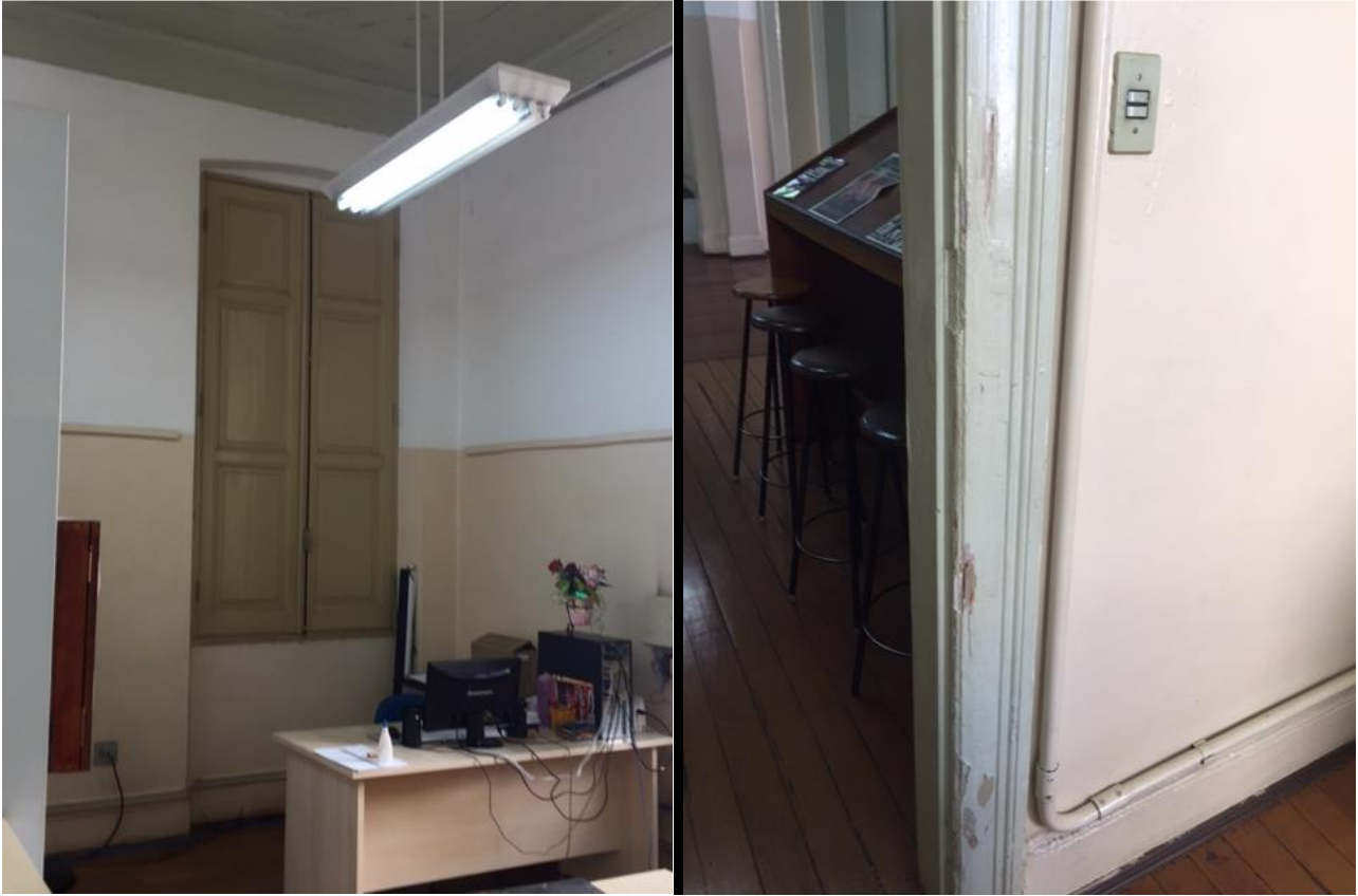
Fotos 34 e 35 - Sala Admin. 2. O batente será removido, pois estão com cupins e estragados e será instalado novo batente, a porta será recuperada. Piso, forro segue como já esclarecido. Fonte: Alessandra de Lima, 2017.
