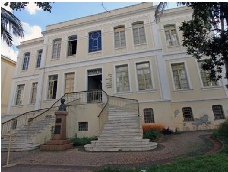
Foto 2 - Fachada Principal Casa da Cultura – Rua São Bento - Pintura nas paredes e revisão das esquadrias e portas. Fonte: internet
