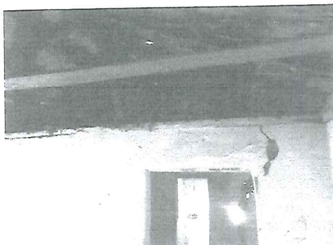
7.b- Rachadura em canto de vão de passagem e trincas acima de porta com partes soltas na alvenaria.
