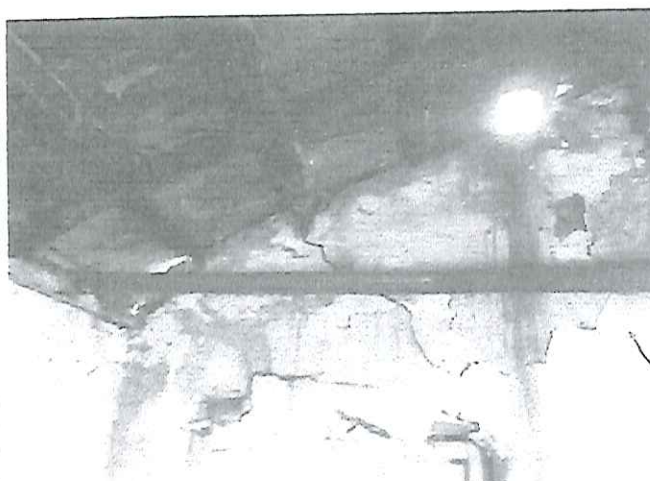
7.b- Rachadura em canto de vão de passagem e trincas acima de porta com partes soltas na alvenaria.
