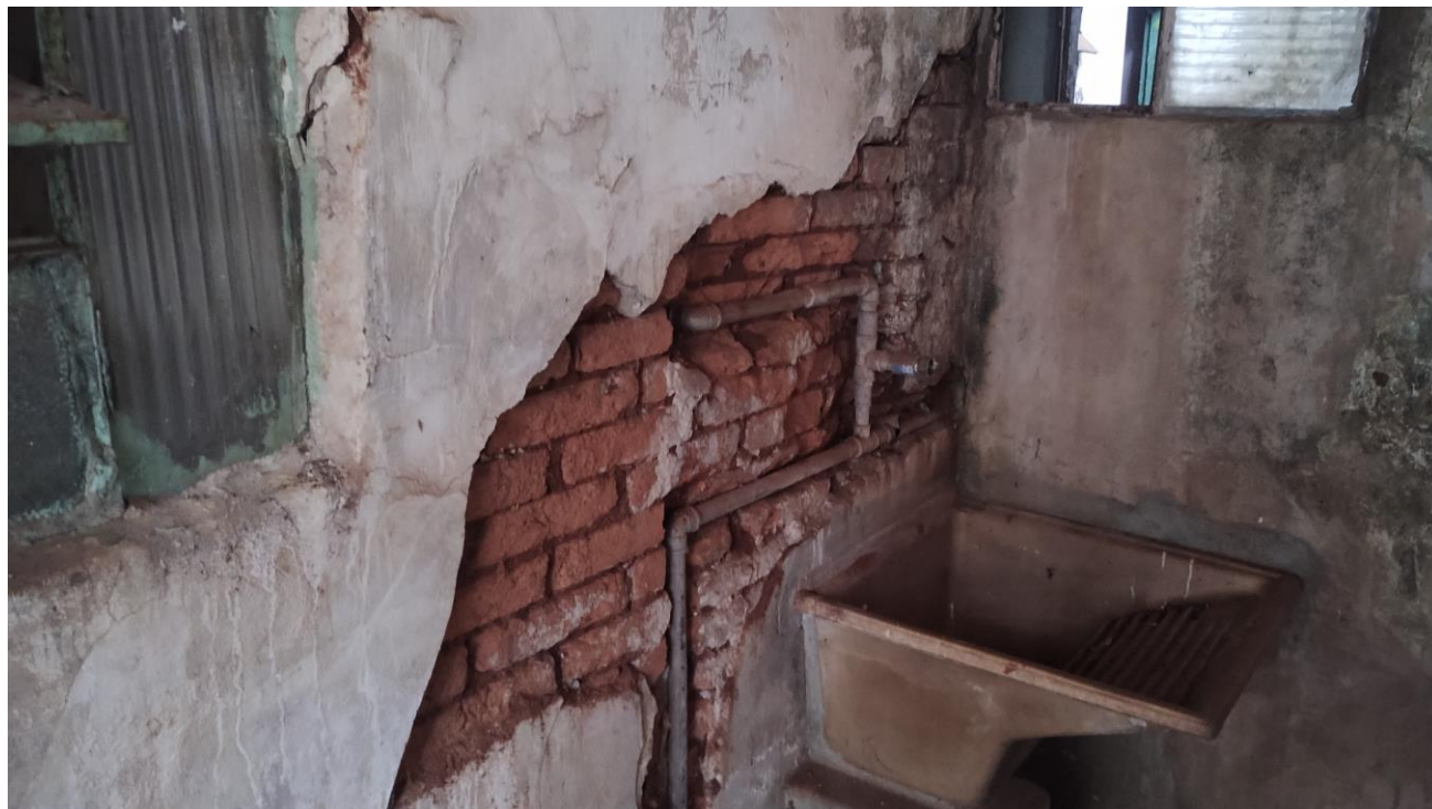
23. Fotos 45, 46, 47, 48, 49, 50 e 51: Situação de risco iminente de desabamento na Cozinha.
