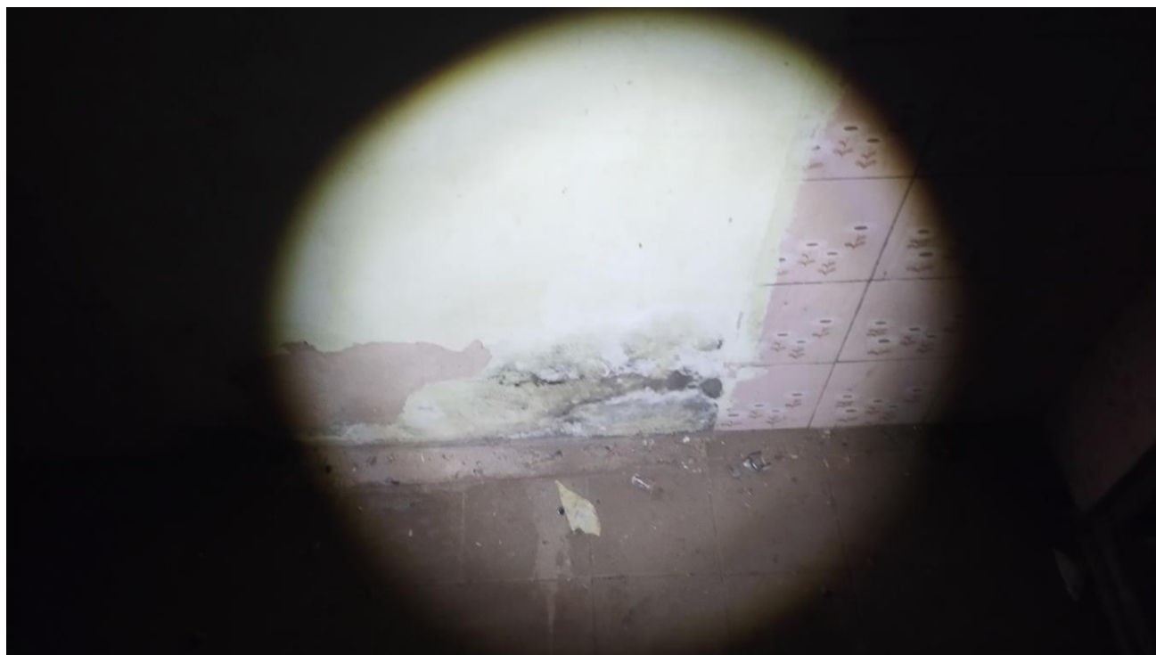
19. Foto 40: Umidade ascendente no Dormitório.
