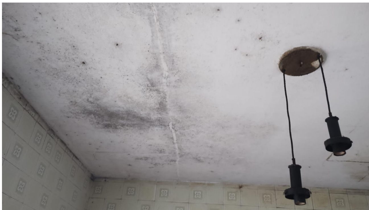
3. Foto 07: Trinca em laje.
