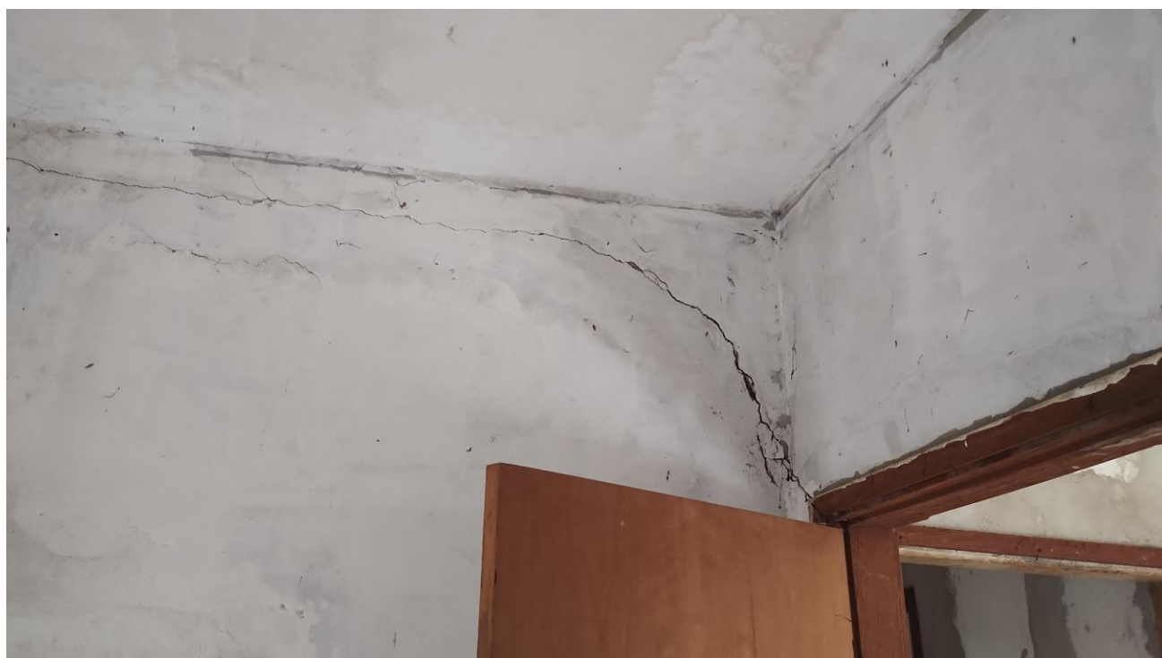
3. Foto 07: Trinca em laje.
