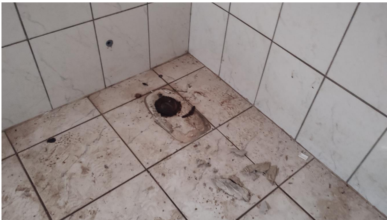
9. Foto 18: Ponto de esgoto aberto.
