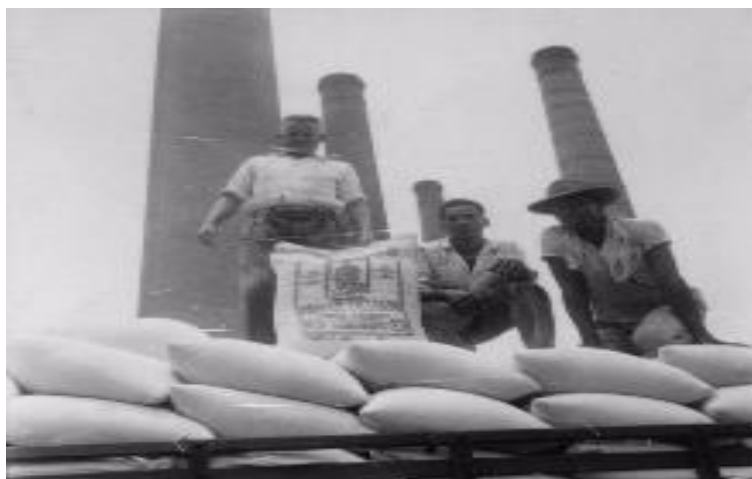
Figura 3: Trabalhadores da Usina Tamoio 4 .
