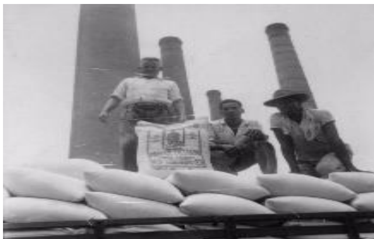
Figura 3: Trabalhadores da Usina Tamoio 4 .
