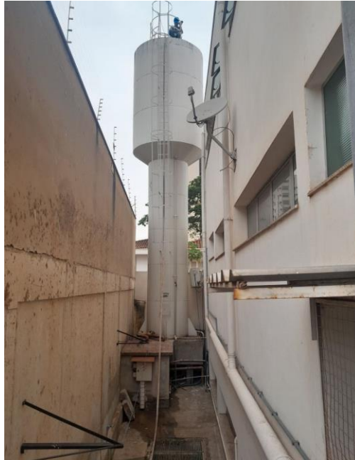
Foto: ( Daae Araraquara) Abastecimento com caminhão pipa - Hospital Maternidade Gota de Leite – Ordem de serviço N.º 2010115/2024
