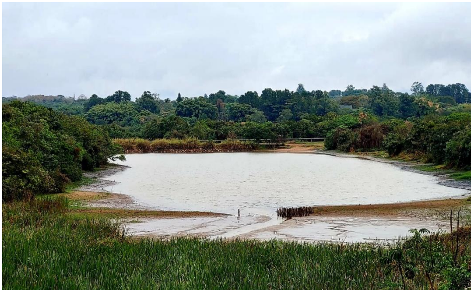
Foto: (Daae Araraquara) Represa que integra sistema de abastecimento com redução de volume em mais de 90%
