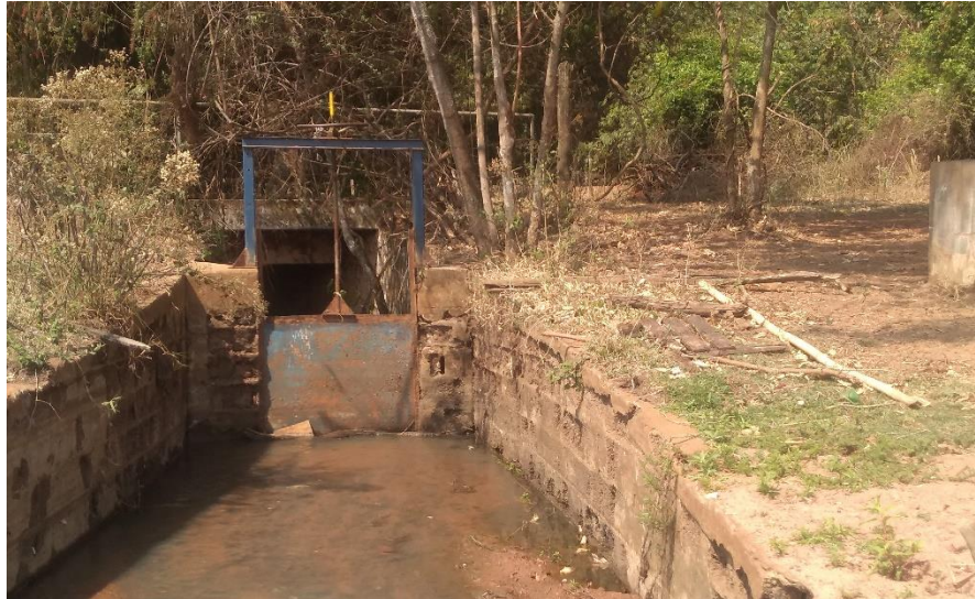
Foto: (Daae Araraquara) Nível de comporta em represa que integra sistema de abastecimento com redução de volume em mais de 90%
