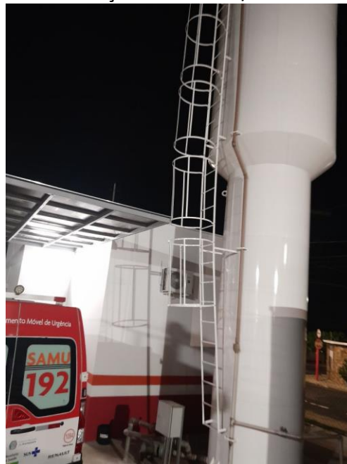
Foto: ( Daae Araraquara) Abastecimento com caminhão pipa – UPA da Vila Xavier – Ordem de serviço N.º 2017171/2024
