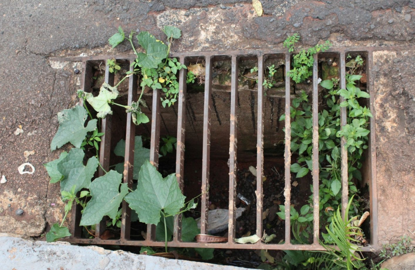
Av. Albert Georges Karan, 18 - Yolanda Ópice LIMPEZA E DESOBSTRUÇÃO DE BUEIRO
