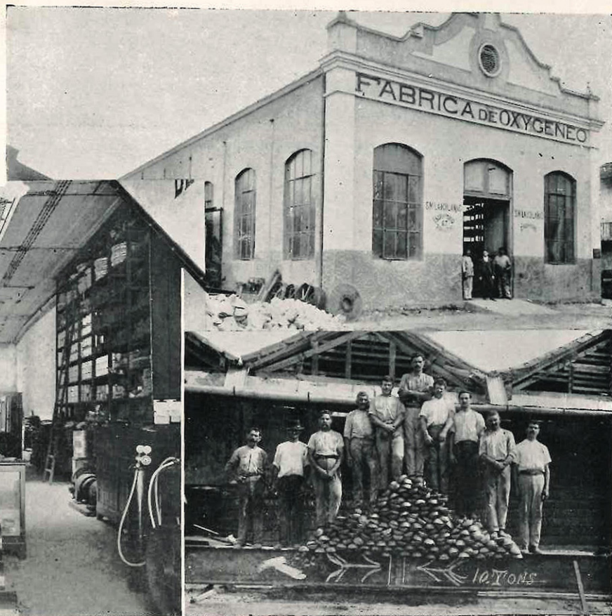
Vista da Fabrica no Rio de Janeiro Duas vigas de 0,50 soldadas pelo processo Oxy-Acetyleno
