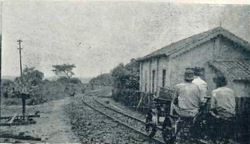
Estação de Espreado, km. 62 Trecho de linha na mesma serra Casa de turma no km. 68
