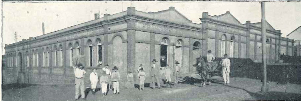
Vista lateral da Serraria
