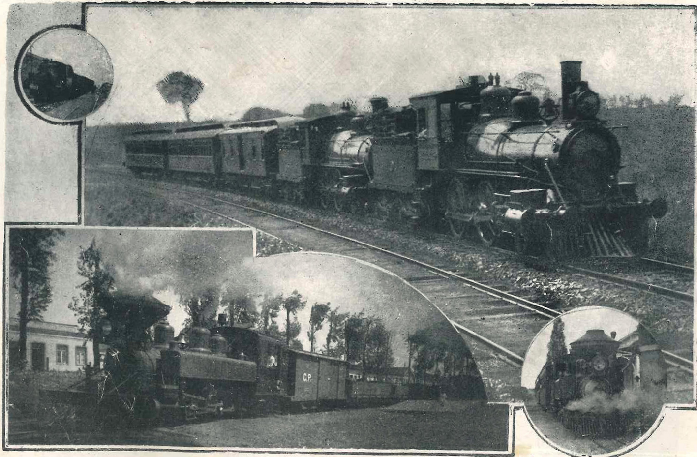
TREM P R 8 NO Km. 117, RAMAL DE DESCALVADO TREM M S 3 DO RAMAL DE Sta. RITA EM PORTO FERREIRA
