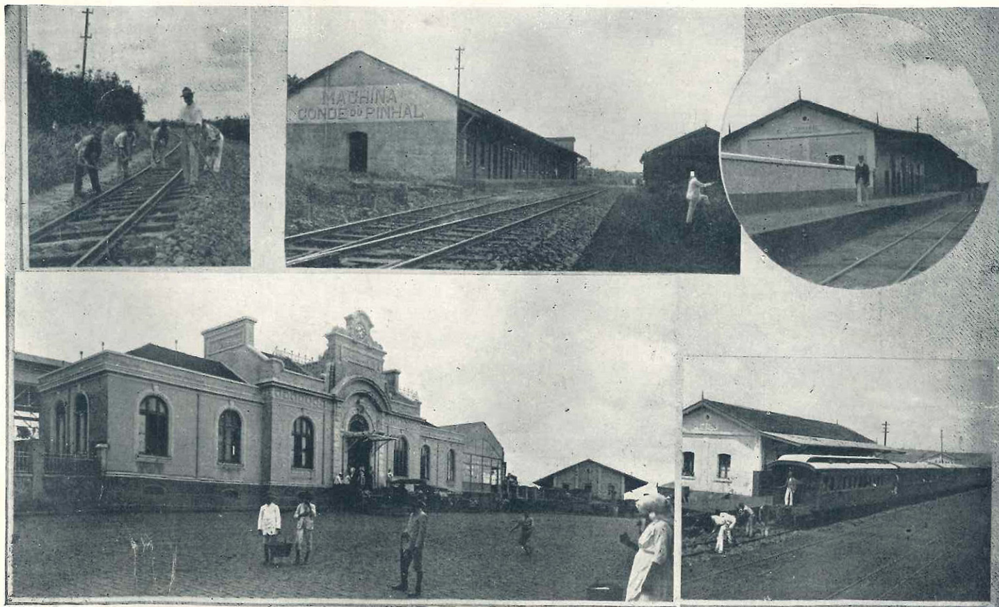
Turma em serviço no km. 129
