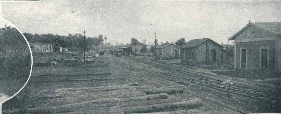
Uma turma substituindo os dormentes Estação de Colina
