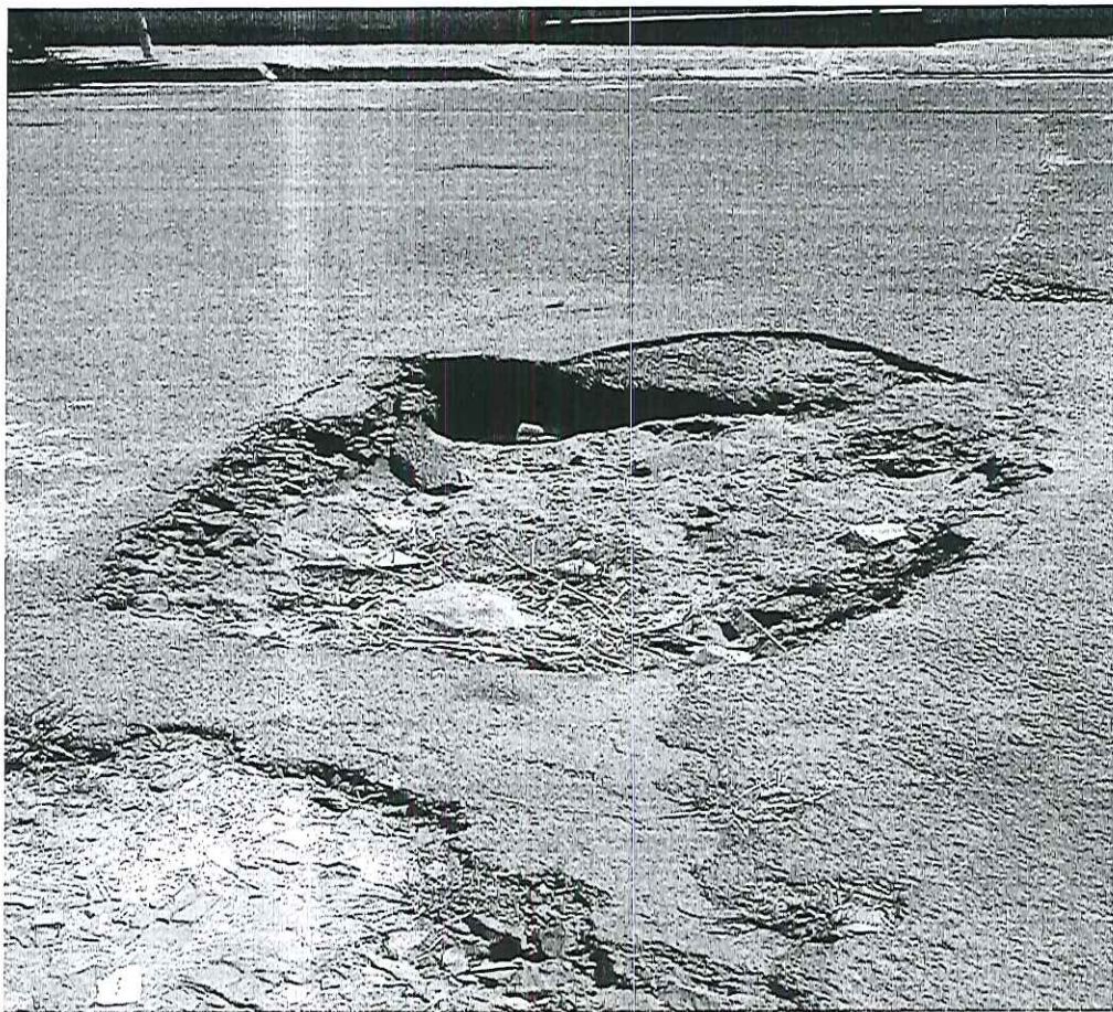
1 - 25.04 – Tapa buraco - Avenida Pedro Grecco, altura n. 247 - Pq. das Hortências
