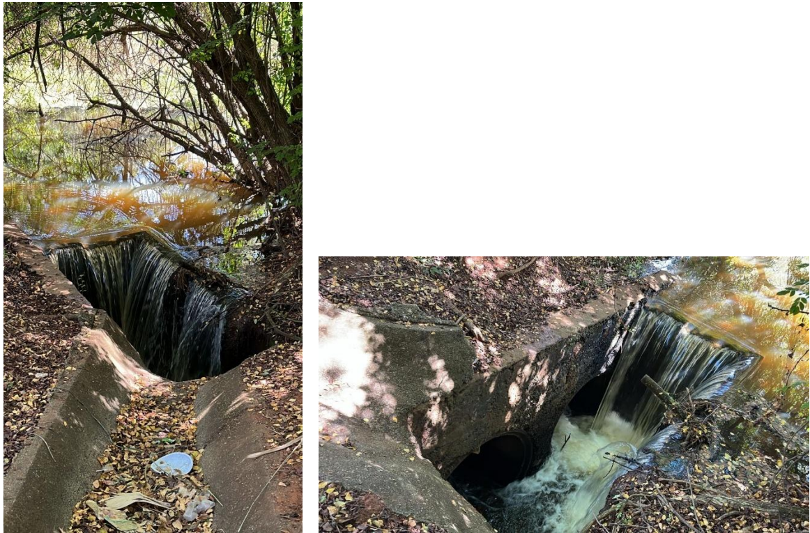
Figura 2 – Caixa de captação do vertedouro
