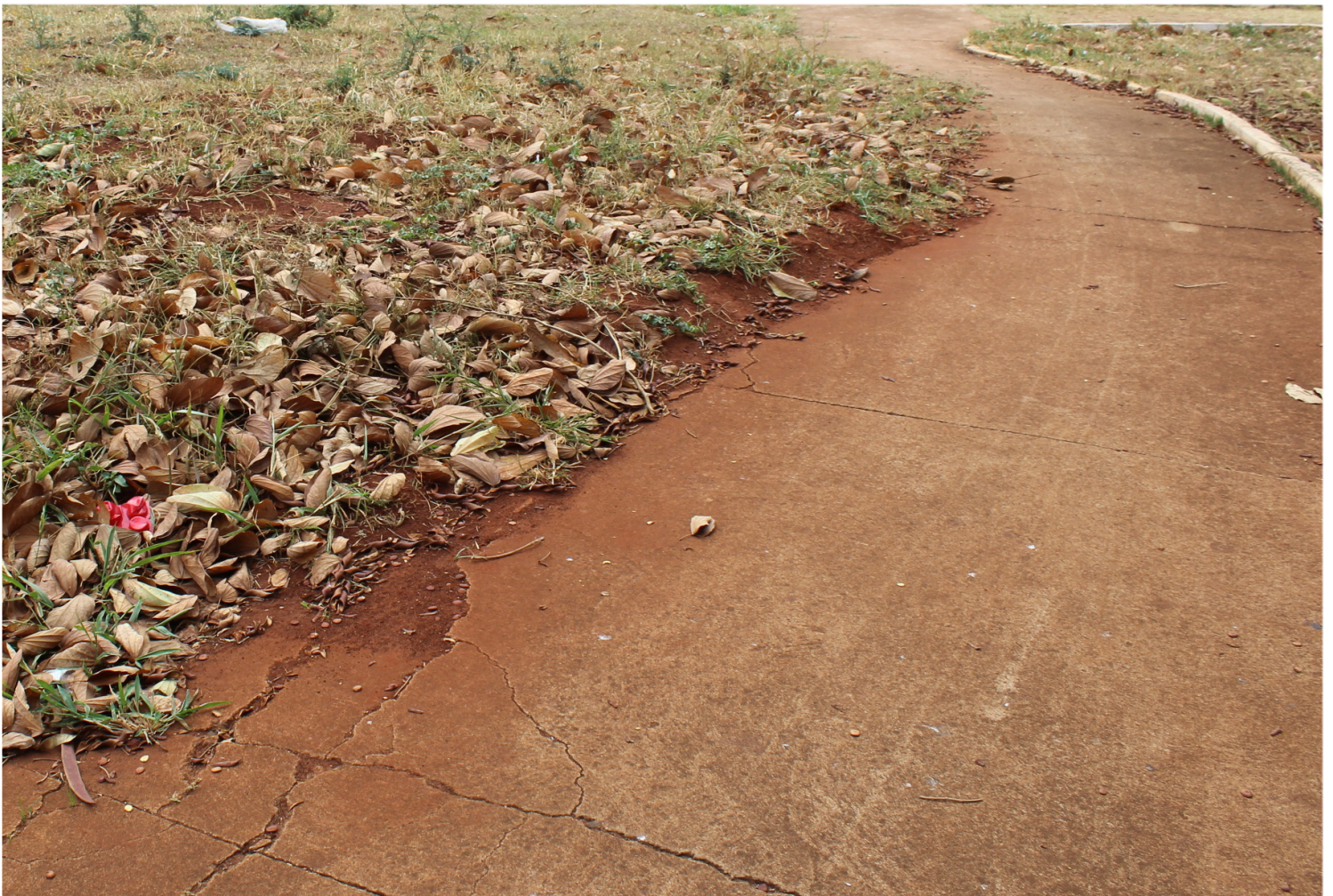
Praça Pública Antônio Moda Francisco - Vale do Sol
