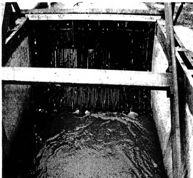
Das três (03) roscas extratoras de areia que compõem as caixas desarenadoras, duas estavam paradas, sem condições de funcionamento e removidas do local, conforme foto abaixo:
