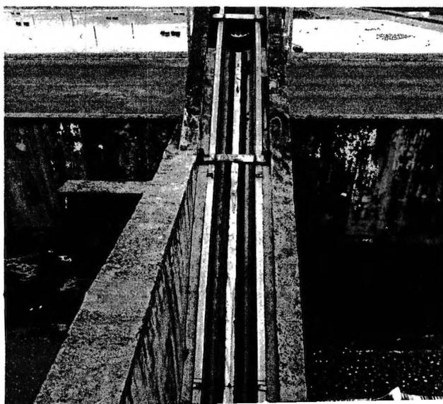
As duas (02) peneiras para gradeamento fino (6 mm) estavam paradas, sem condições de funcionamento, retiradas do local e colocadas no pátio, conforme foto abaixo:
