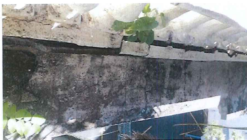
Foto 16: Vegetação nas fendas da platibanda – lateral (Av. Portugal), deverá ser retirada.
