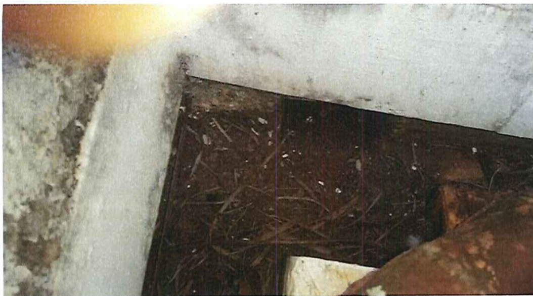
Foto 4 - Calha/bocal de condutor
