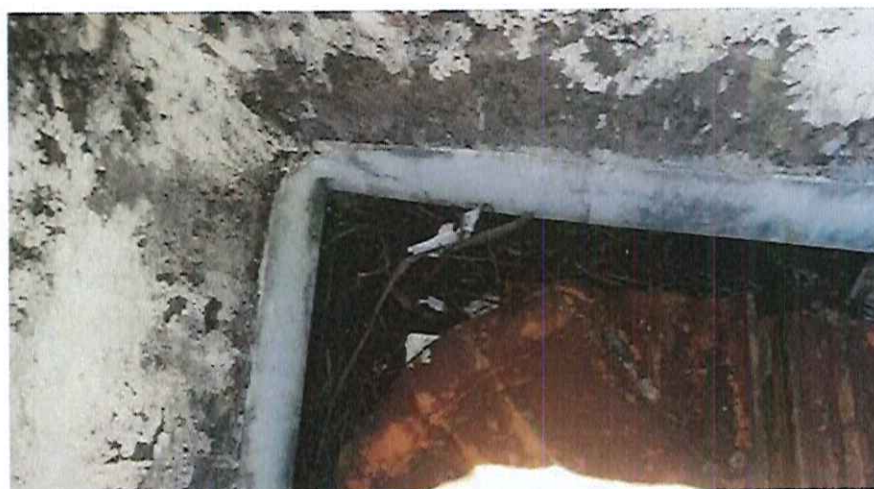
Foto 3 - Calha/bocal de condutor
