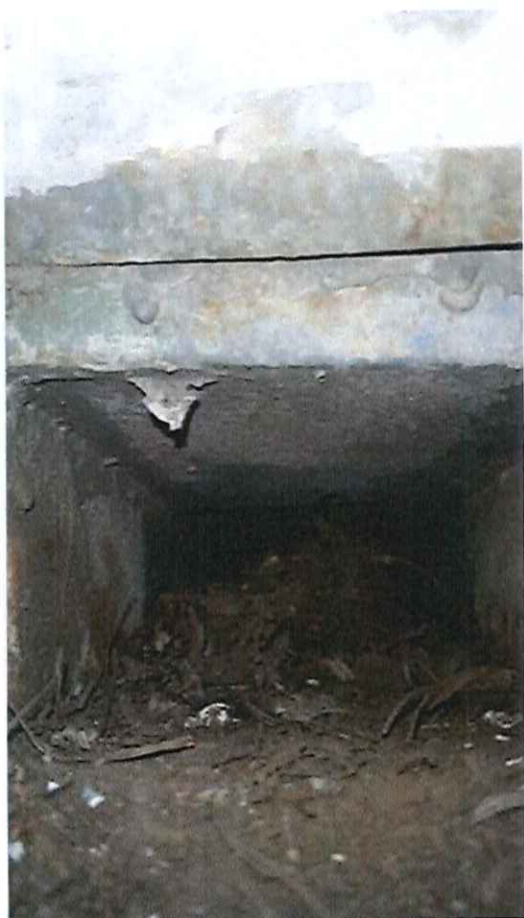
Foto 5 - Bocal de condutor - vista interna
