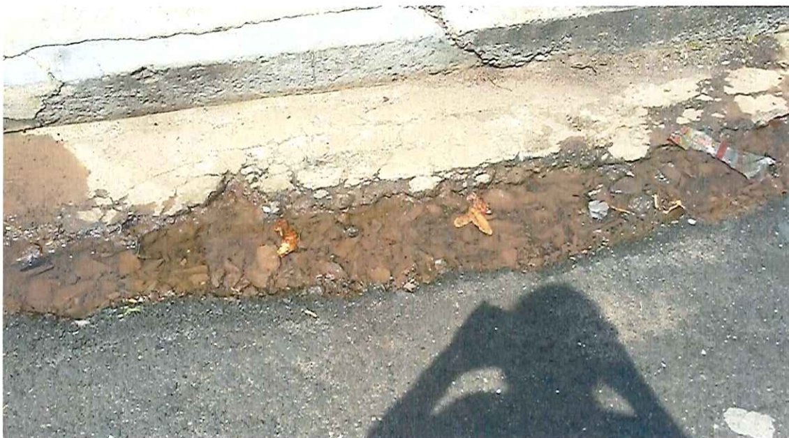
ANEXO 230 Limpeza e canaleta na Rua Manoel Marques de Jesus esquina com Avenida Prof Nicolau Jorge Lauand- Vila Xavier
